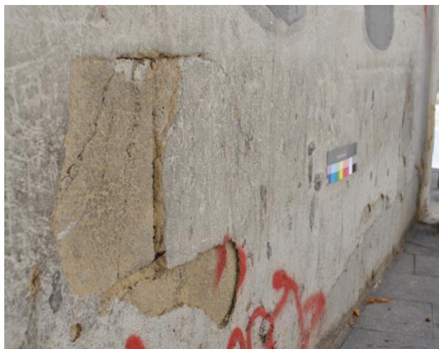
Figura 3. Detall de faltant de pel·lícula pictòrica i morter, que permet determinar l'estratigrafia.
