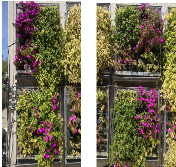
Figura 8 | Desarrollo del material vegetal para muros verdes con sustrato de mezcla de cascarilla de arroz y fibra de coco.
