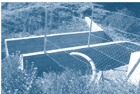
Figura 4. Obra de aforo en la cuenca del arroyo de Valdelamasa
