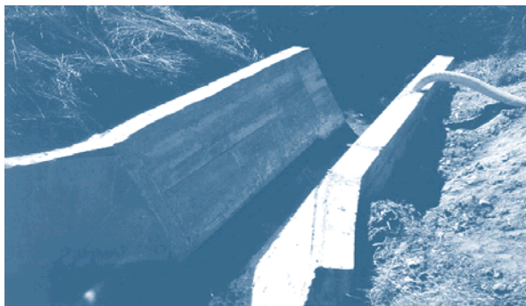
Figura 3. Obra de aforo en la cuenca del arroyo del Monte
