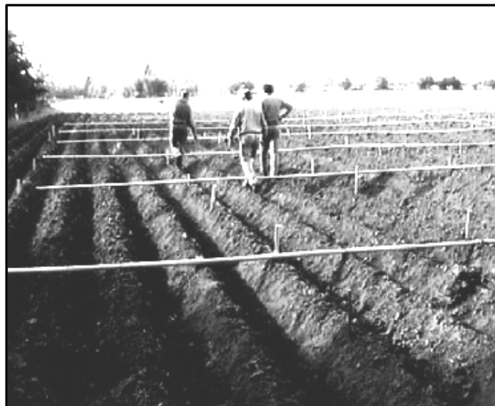
Figura 1. Instalación de un sistema RGS, Río Cuarto, Córdoba, Argentina
