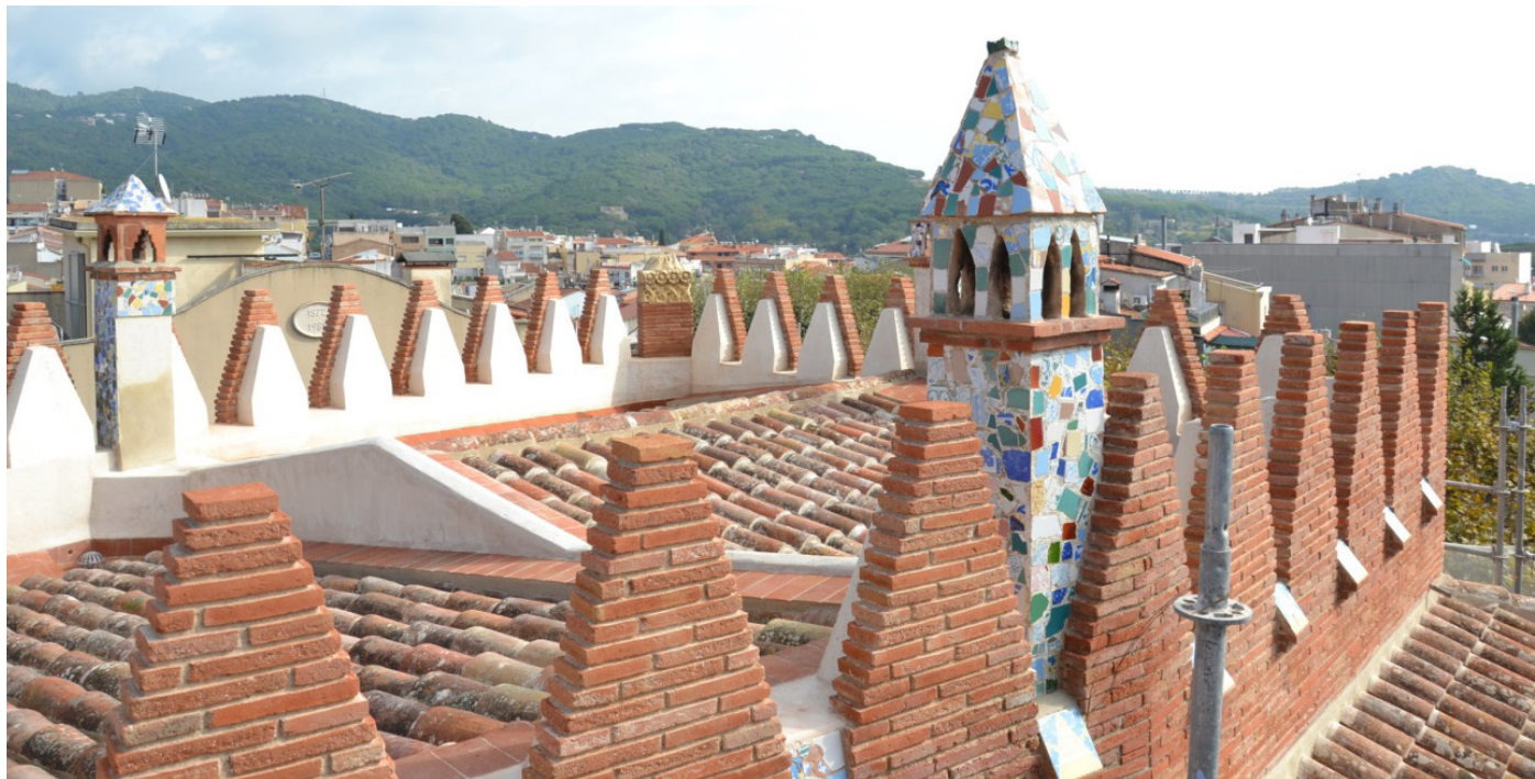
Remate de la fachada tras la rehabilitación / Facade finish elements after the rehabilitation
