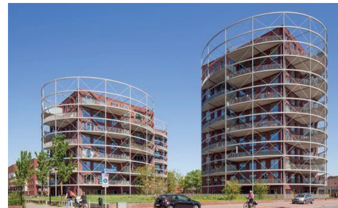
Las torres de gas tras la intervención
