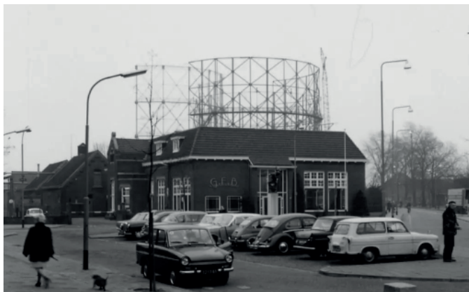
Las torres de gas antes de la intervención
