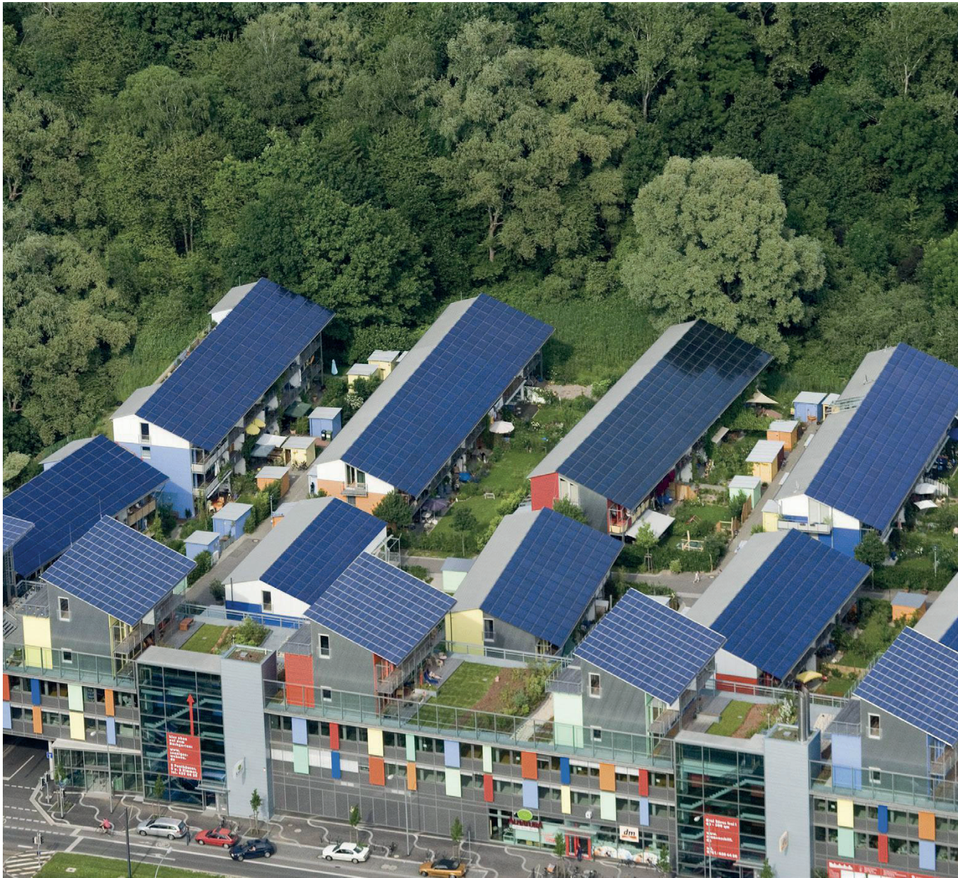
Vista aérea del proyecto
