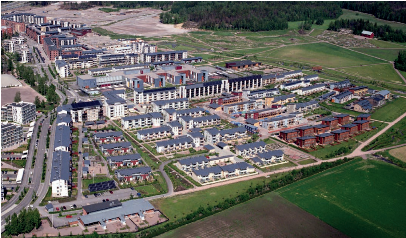
Vista aérea desde la que es posible apreciar la estructura en dedos
