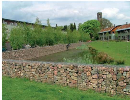
Vista detalle tratamiento del agua y gaviones
