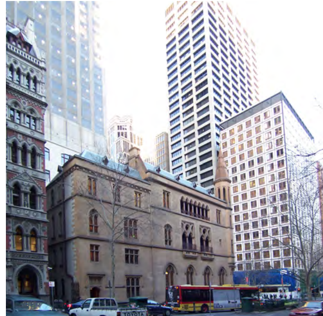
1. Catedral de San Pablo, Melbourne, 1880-81, arenisca Waurn Ponds y Barrabool
