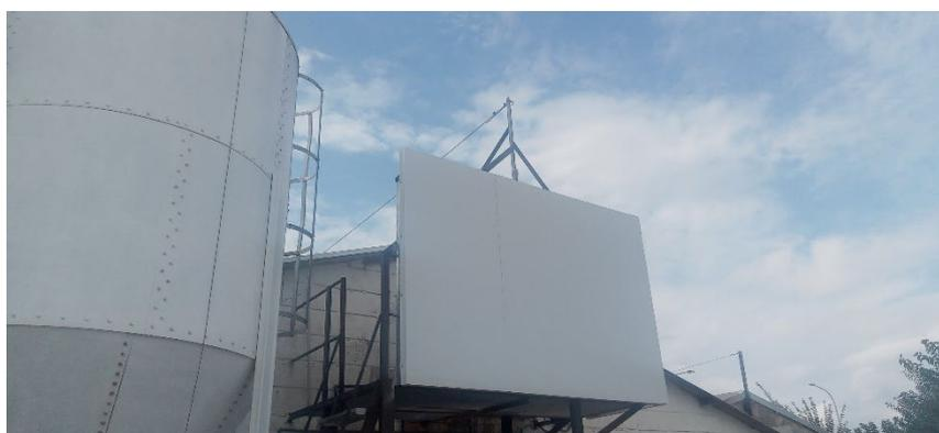
**Ilustración 4: Pantalla de insonorización del cooling de las Granjas.**
