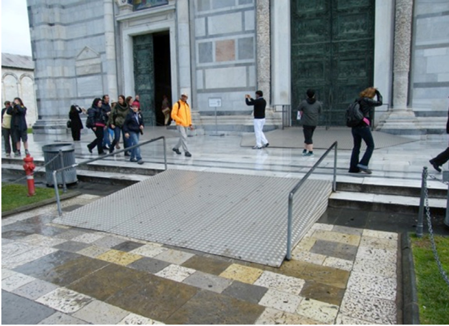
Fig. 1: Rampa de acceso en un entorno monumental como el de Pisa, Italia.
