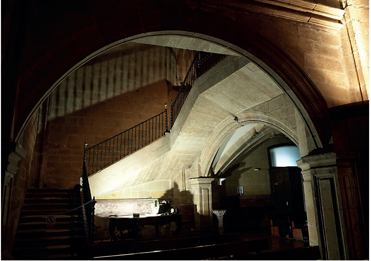
Figura 3. Vista del conjunto de la escalera desde el este (imagen de los autores).
