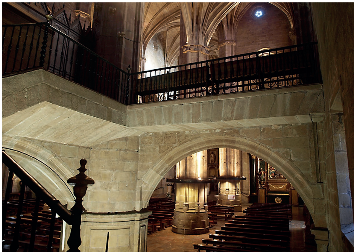
Figura 4. Vista del conjunto de la escalera desde el oeste (imagen de los autores).
