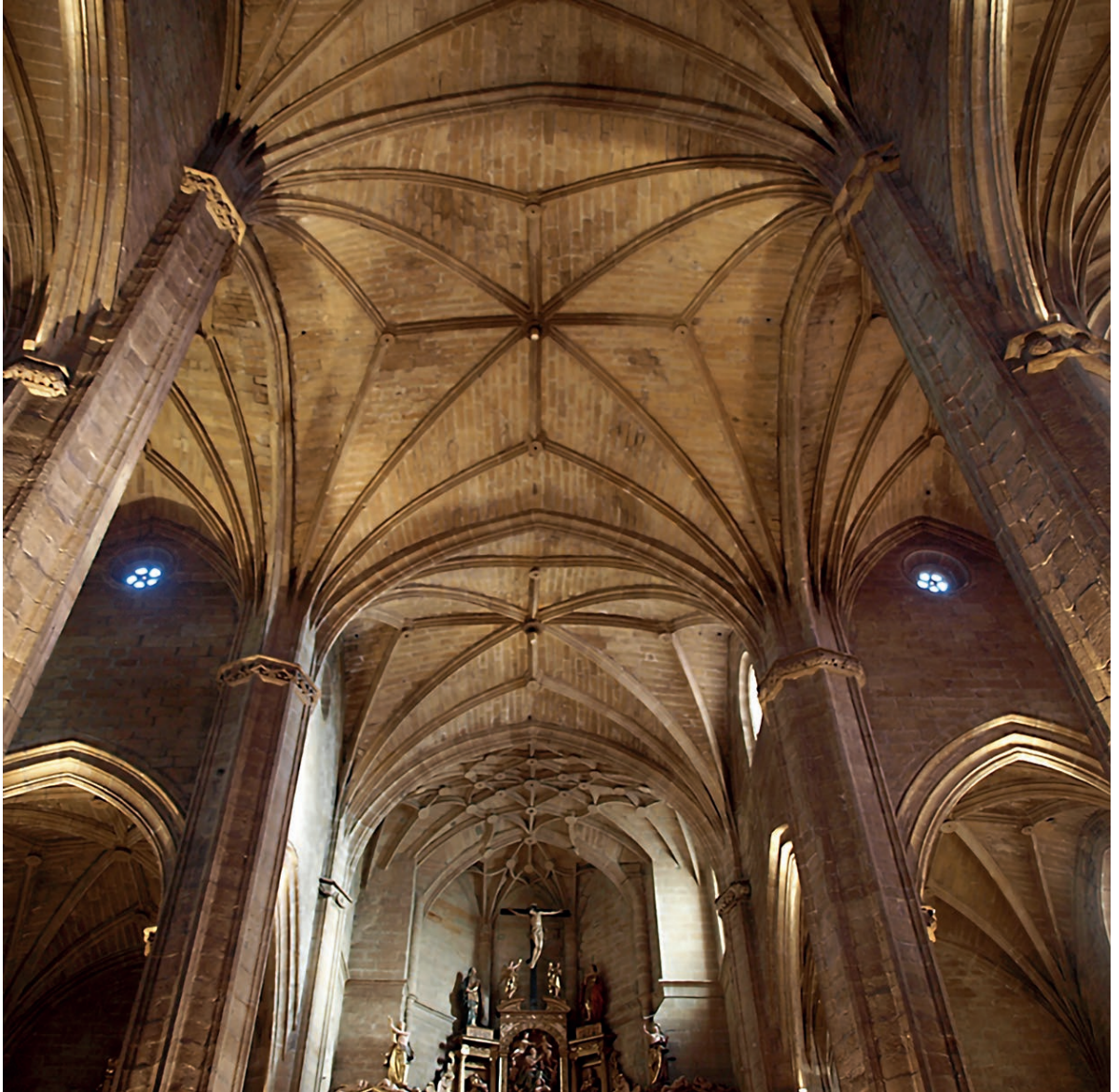
Figura 1. Vista general interior de la iglesia de San Vicente (imagen de los autores).
