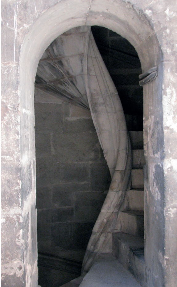
Figura 20. Interior del caracol de ojo de la Sacristía Mayor de la catedral de Sevilla desde la cubierta de las capillas perimetrales. (Foto del autor).
