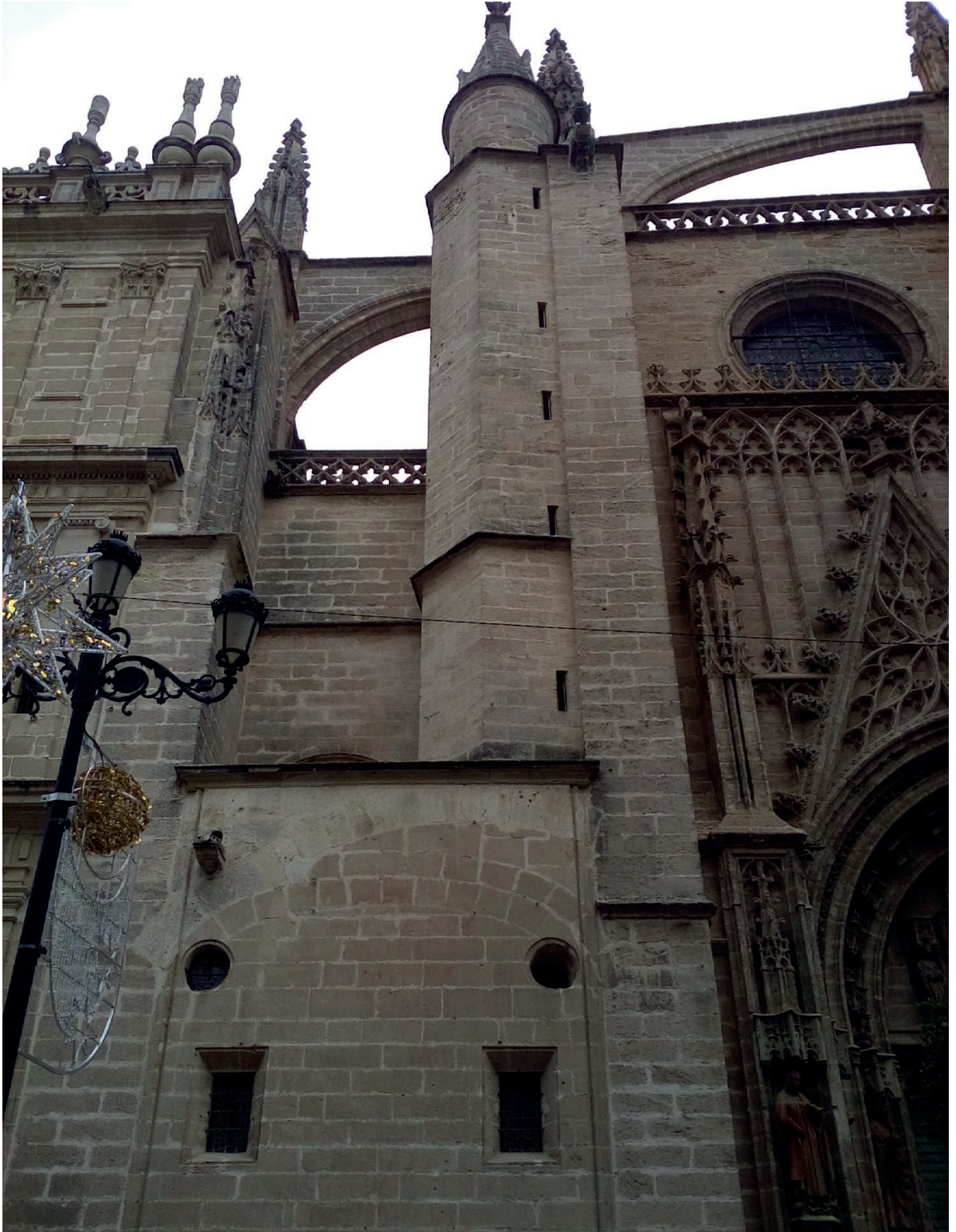
Figura 10. Detalle de la escalera de los Jácome desde el exterior (Foto del autor).
