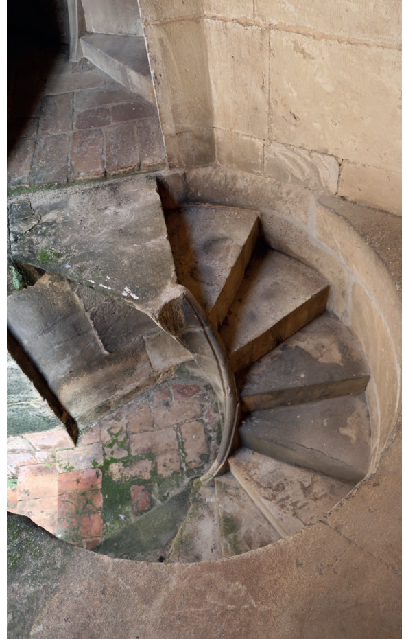
Figura 21. Caracol interrumpido sobre la cubierta del Antecabildo (Foto del autor).
