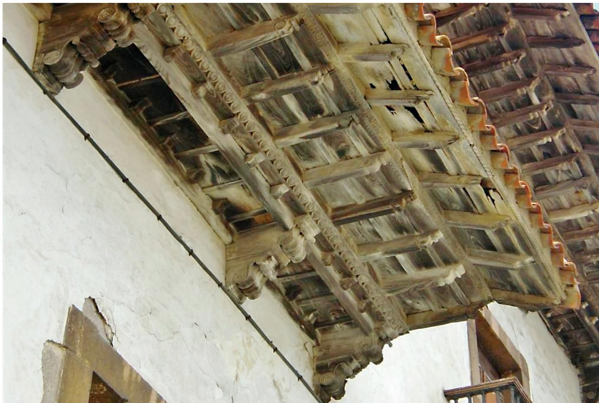
Figura 17. Palacio Méndez Pola (s. xvii) en Luanco, Asturias. Alero compuesto formado por tres órdenes, los dos inferiores horizontales y el superior inclinado. El primer orden tiene carrera con ménsulas independientes de los canes y se apoya en una carrera de vuelo. El segundo vuela sus canes sobre el primero. Ambos disponen de una moldura de borde o cimacio. El tercer orden está formado por el vuelo de los pares del tejado (foto del autor, 2007).
