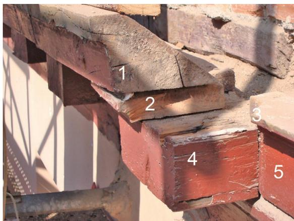
Figura 23. Corte de las piezas de un alero: 1 Cimacio; 2 Tocadura; 3 Saetín; 4 Can; 5 Tabica (foto de los autores, 2012).
