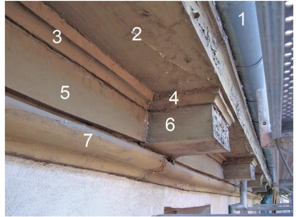
Figura 22. Elementos de un alero: 1 Canalón; 2 Cimacio; 3 Saetín; 4 Tocadura; 5 Tabica; 6 Can; 7 Gola (foto de los autores, 2007).
