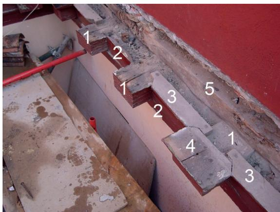
Figura 24. Desmontaje de un alero: 1 Can; 2 Tabica; 3 Saetín; 4 Tocadura; 5 Estribo (foto de los autores, 2012).
