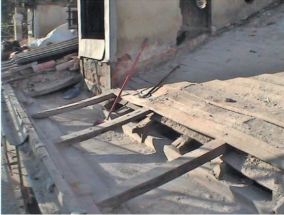
Figura 20. Falsos pares y ensillado en el alero de un edificio madrileño de 1880 (foto de los autores, 2003).
