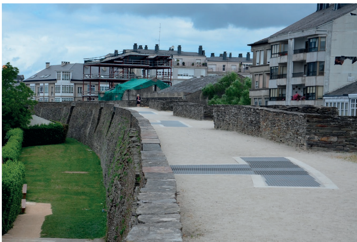
Figura 10. Vista del adarve entre la Puerta de San Pedro y la Puerta de la Estación.
