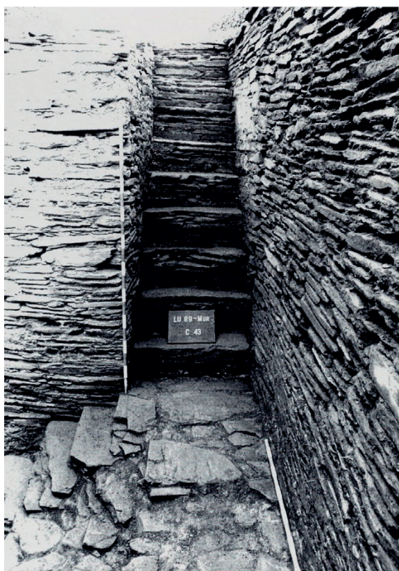
Figura 8. Tramo de escalera (1990). 33
