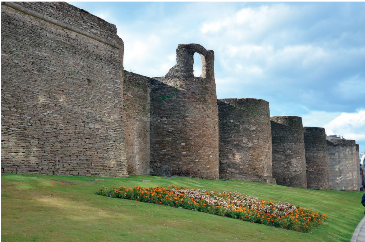
Figura 11. Vista exterior de la Muralla de Lugo, en el tramo Ronda de la Muralla, 21 al 78.
