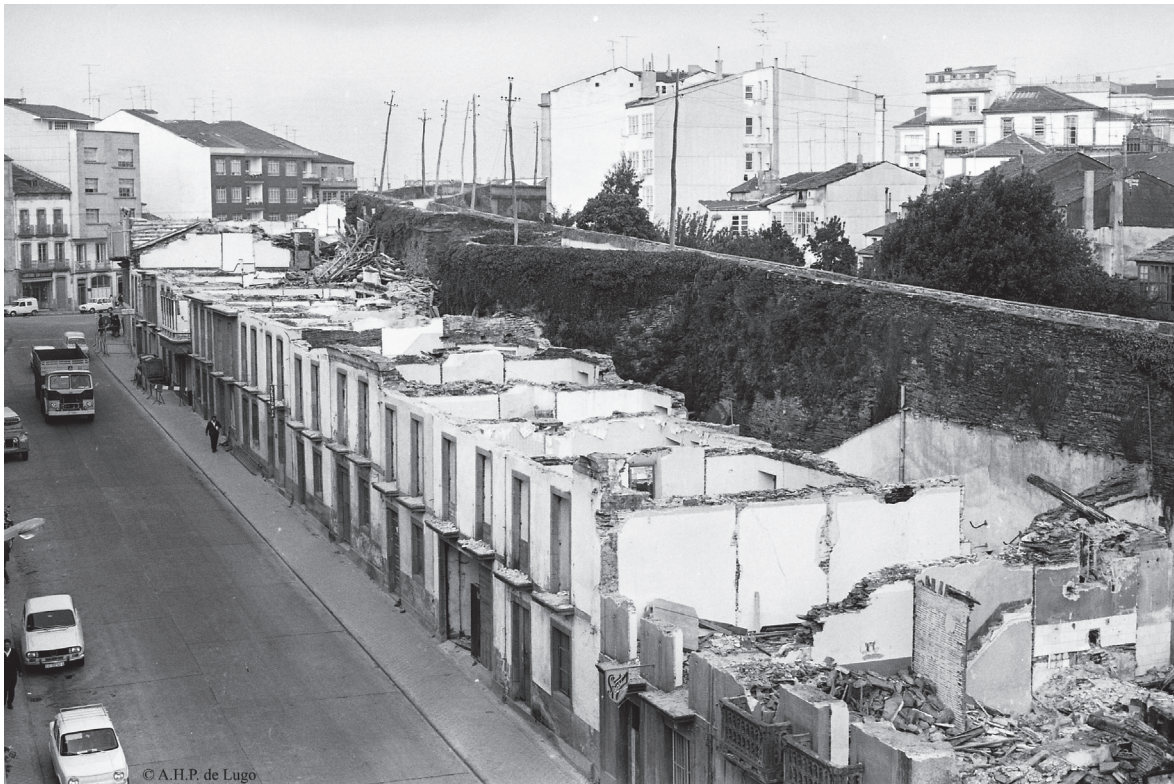
Figura 4. Casas en demolición (1972).
