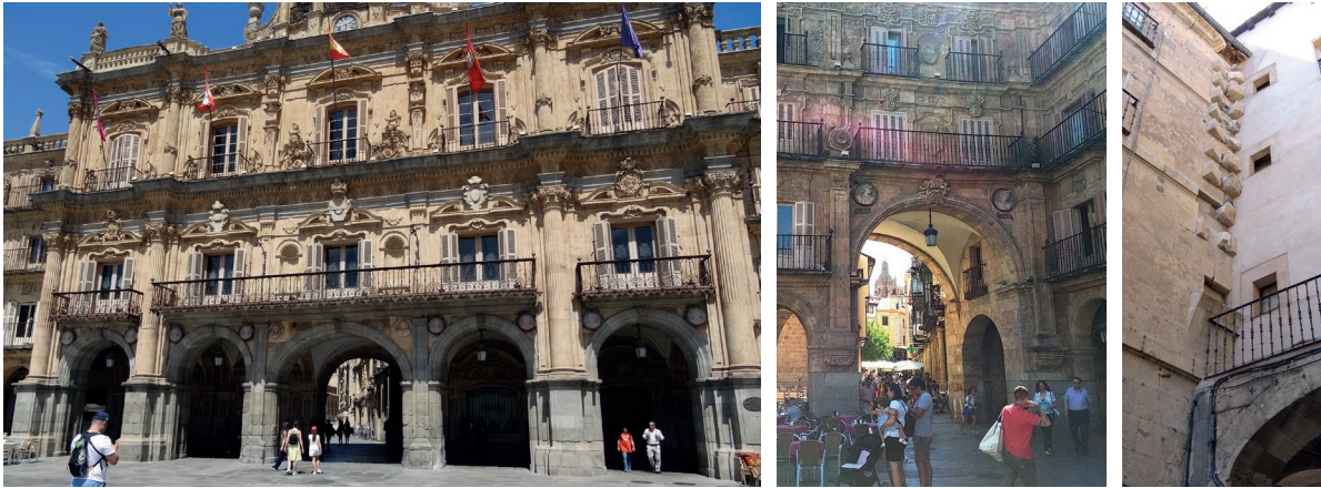
Figura 4. Ayuntamiento con la calle Zamora pasándole por debajo. Figura 5. Rincón suroeste: arco de san Martín. Figura 6. Adarajas en el rincón noreste, sin cerrar, salvo la galería.
