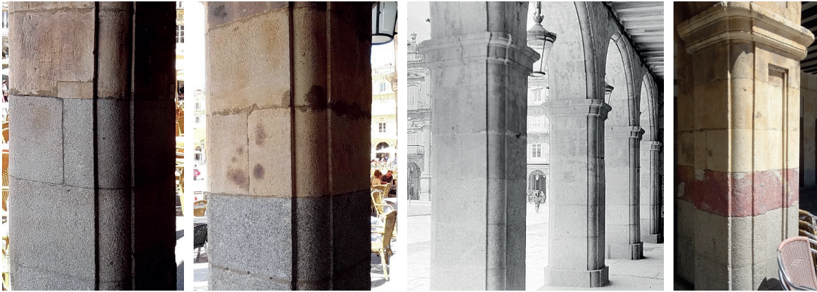
Figura 33. Hilada con dos sillares de granito y juntas cuidadas. Figura 34. Hilada con dos sillares de arenisca y juntas cuidadas. Figura 35. Sillares de granito antes de 1927. Foto de 1920-22. Fototeca del IPCE. Fondo Wunderlich WUN-04889. Figura 36. Hilada roja ¿de piedra tosca de la Pinilla? embocando la calle del Concejo.
