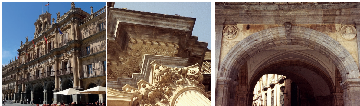
Figura 27. Cornisa corrida común en la planta segunda de Plaza y Ayuntamiento. Figura 28. El granito protege a la arenisca en la fachada bicolor).
