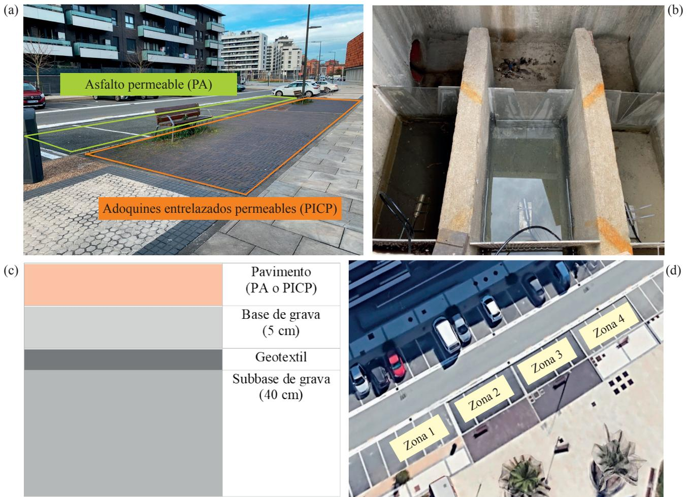
**Figura 1** | La zona de estudio. (a) Fotografía del aparcamiento con pavimentos permeables en Txomin-enea, Donostia-San Sebastián. (b) Fotografía de la arqueta con tres canales: el que recoge agua de escorrentía (a la izquierda), el que recoge el agua que ha atravesado el asfalto permeable (PA) (en el centro) y el que recoge el agua que ha pasado por los adoquines permeables (PICP) (a la derecha). (c) La sección de los pavimentos permeables. (d) Vista de la zona de estudio.
