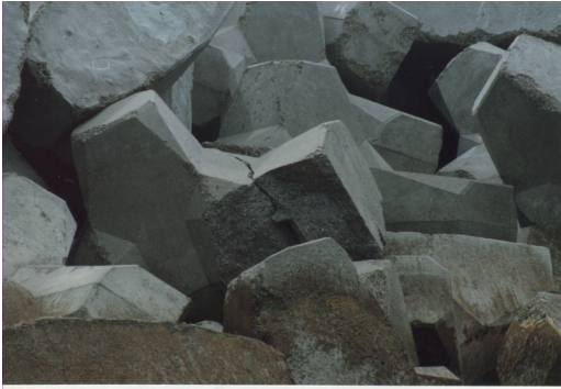
Figura 2 | Asentamiento y rotura de elementos Accropode® de 6.3 m 3 y 9 m 3 ante eventos de diseño.
