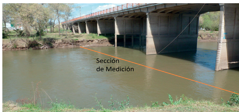
Figura 2 | Sección de aforo aguas abajo del puente Juan Bautista Alberdi de la ciudad de Villa María en el río Tercero.
