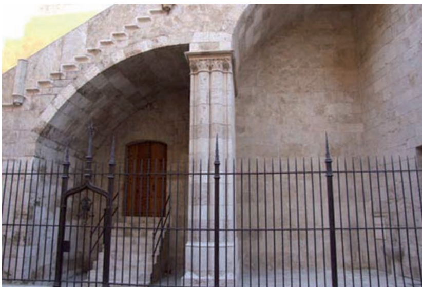
6 y 7. Imágenes correspondientes al estado previo a la intervención de Soler, donde se aprecian restos del recinto carcelario 8. Vista general de la eja de forja restaurada delante de la escalera neogótica realizada por Rieta
