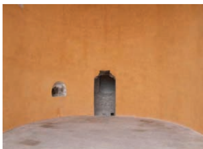
25 y 26. Estado inicial y final del revoco interior, donde además de reintegrar el color original se han eliminado las humedades
