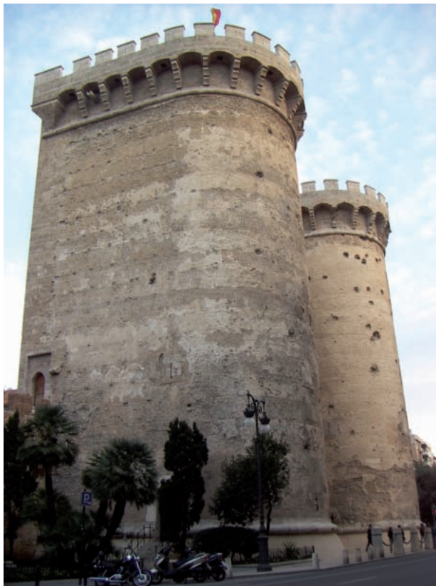
1. Aspecto final del exterior. Fachada delantera
