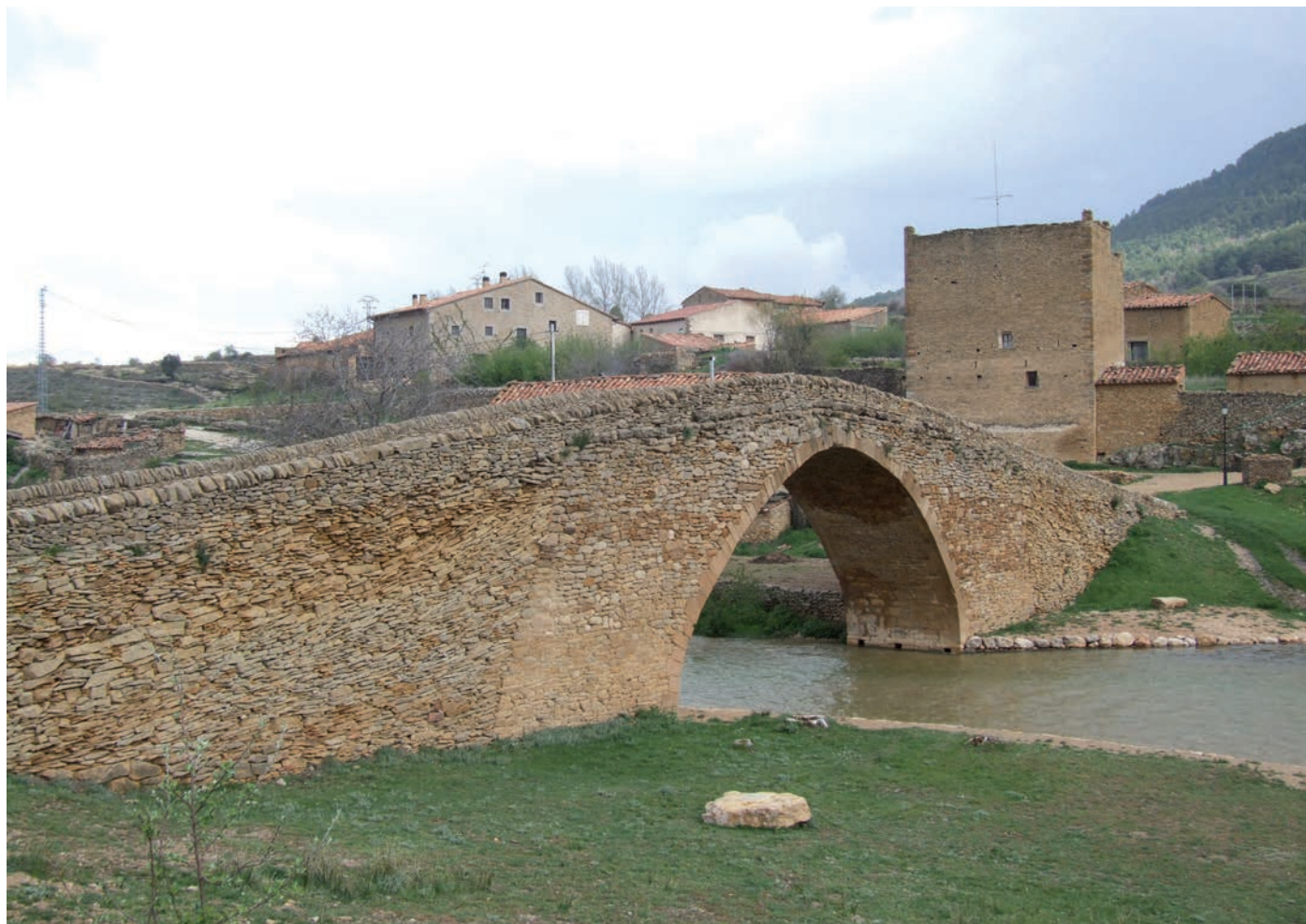
1. Vista del puente restaurado con la torre defensiva que controlaba el paso (Mileto & Vegas)
