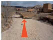
2.- Vista del Cauce aguas abajo. Se aprecia el ensanchamiento del cauce y la posición lateral del ojo del puente respecto al mismo.
