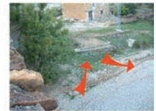
8.- Manguardía existente. Elemento de protección del edificio en los casos de fuertes avenidas.
