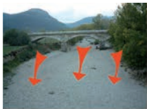
1.- Vista aguas abajo del Puente Nuevo. Se aprecian la distribución de los tres ojos separados por tajamares triangulares. La construcción del nuevo puente ha causado el ensanchamiento del cauce y la desviación de las corrientes.
