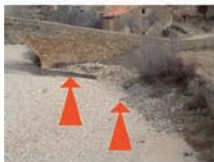
5.- Zona de Riesgo 1. Demarcación de las medidas preventivas. Manguardía y trasdosado de zahorras para evitar el arrastre de finos y la incidencia directa del agua sobre el puente.
