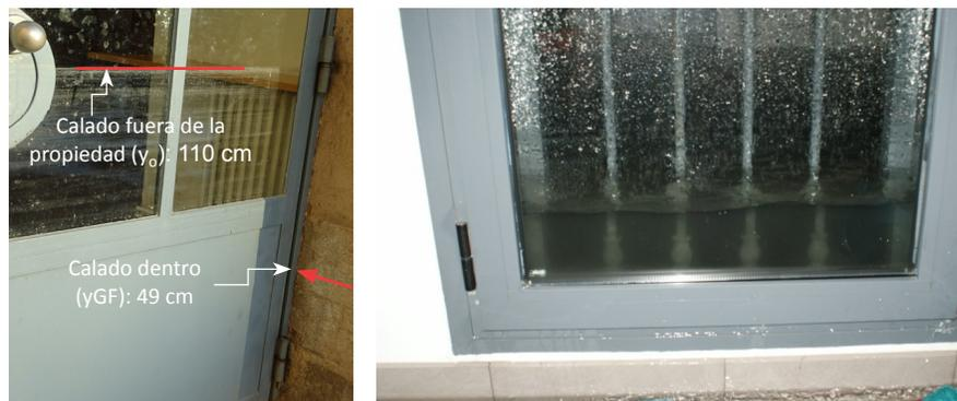
Figura 5 | Marcas de los calados alcanzados por el agua tras un evento de inundación, en el interior y exterior de la propiedad
