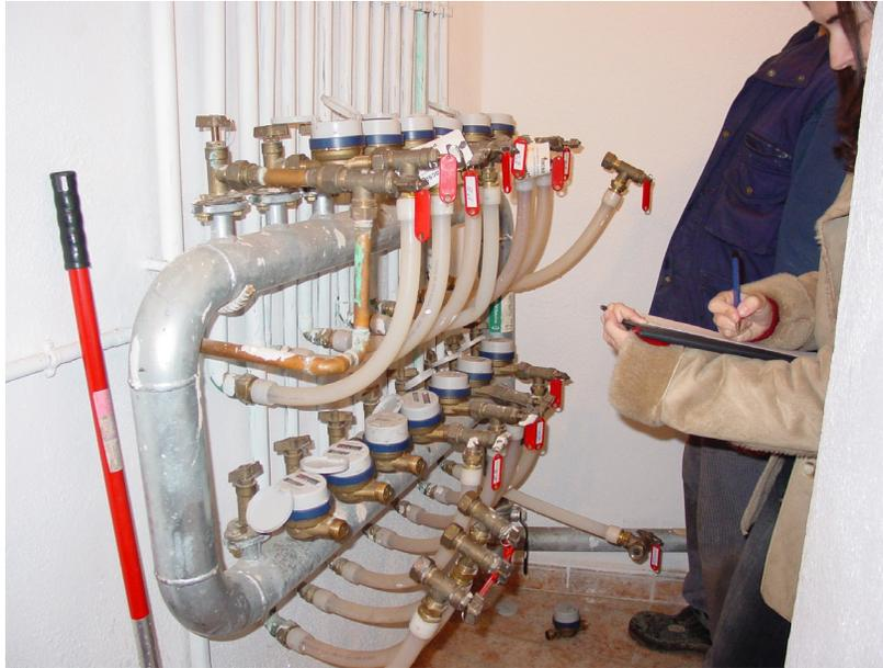
**Figura 2** | Contadores de agua instalados en batería dentro de un edificio.
