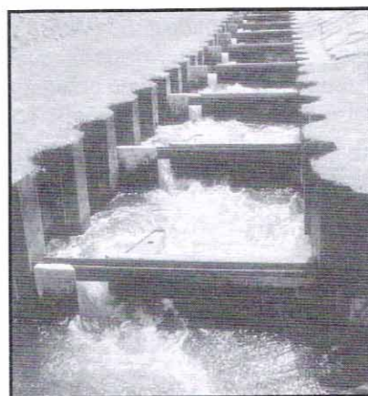
Figura 3. Izquierda: Escala de hendidura vertical, diferentes configuraciones de los tabiques que conforman las piscinas: de simple o de doble hendidura (Odeh, 1999). Derecha: Escala de peces de hendidura vertical en Francia, escala de Méricourt en el río Seine (Larinier, 1998).
