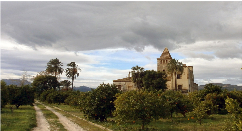
La Torre dels Pares vista des de dins de la parcel·la.
