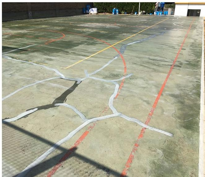
Fig.c. Tratamiento de juntas con Eporip de Mapei
