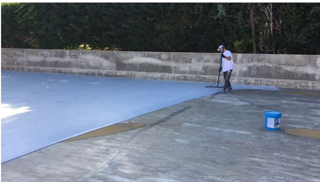
Fig. f. Aplicación de capa base de Mapecoat TNS Base Coat
