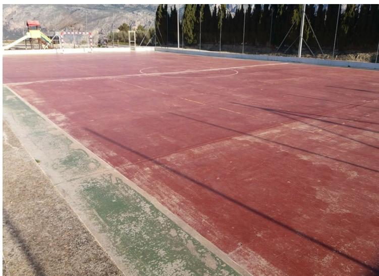
Imagen 8. Pavimento de hormigón fratasado deteriorado
