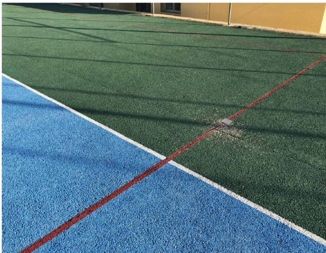
Imagen 3. Lesiones en pista de hormigón drenante
