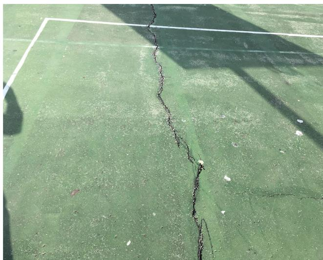
Imagen 19. Pavimento asfáltico agrietado
