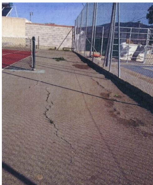
Imágenes 16 y 17. Pavimento asfáltico agrietado
