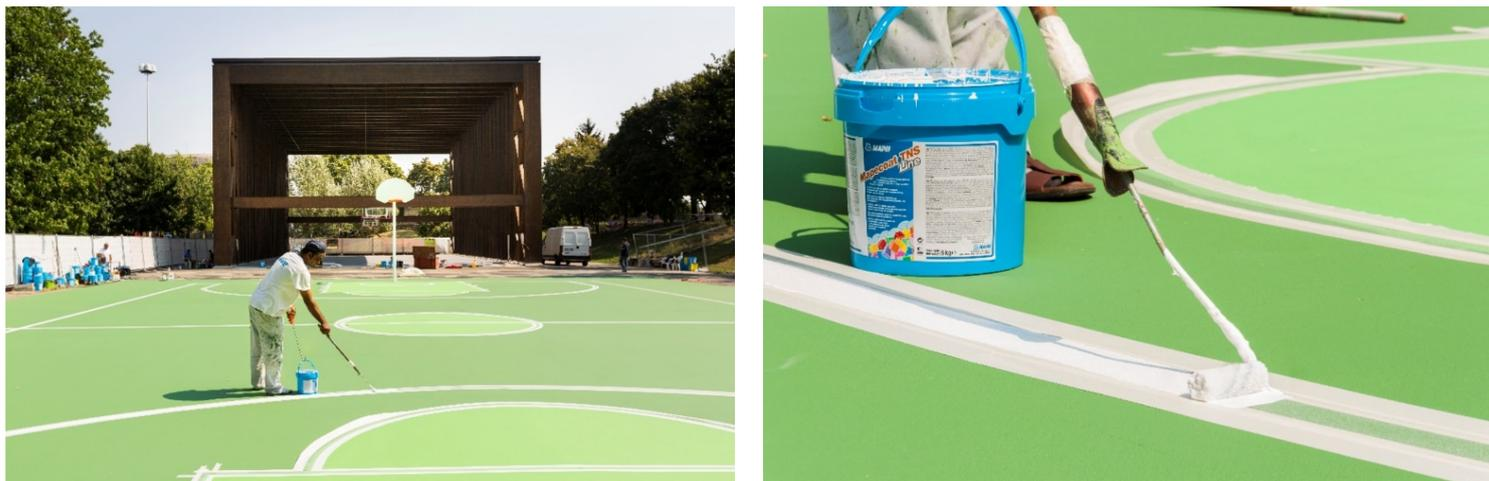
Fig. i. Aplicación de capa base de Mapecoat TNS Line
