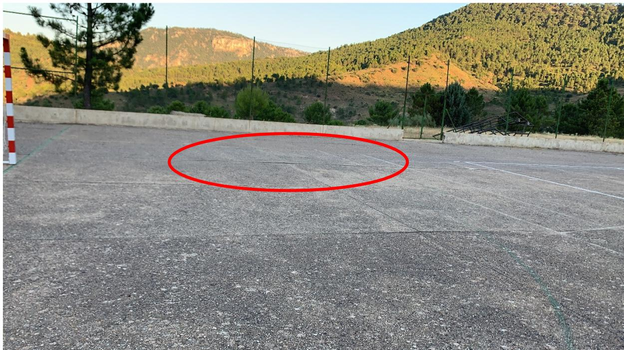
Imagen 7. Pista polideportiva con hundimiento de unas pastillas respecto a otras
