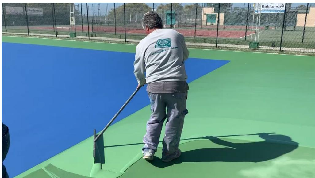
Fig.h. Aplicación de capa base de Mapecoat TNS Color
