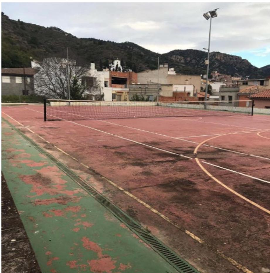
Imagen 13. Pista de tenis deteriorada sobre hormigón fratasado
