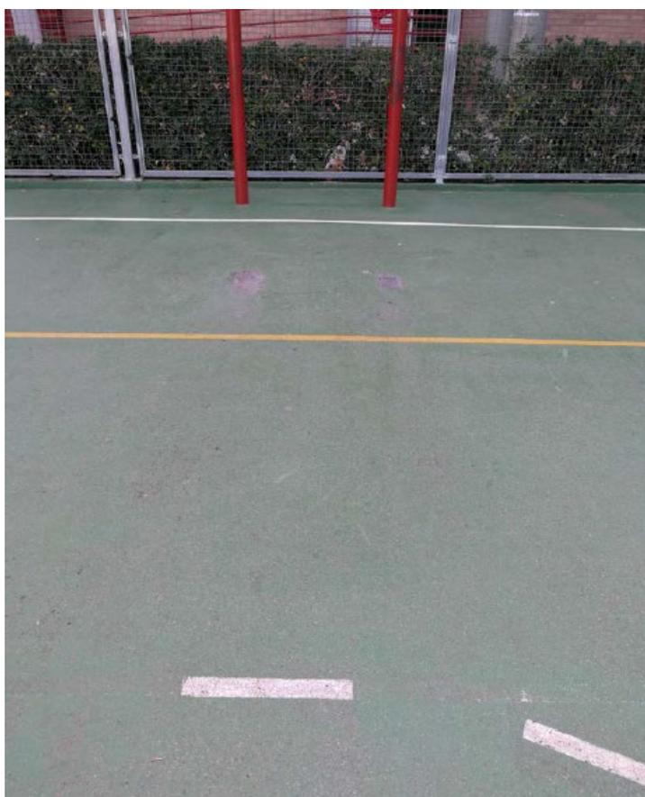
Imagen 2. Lesiones en pista de hormigón drenante
