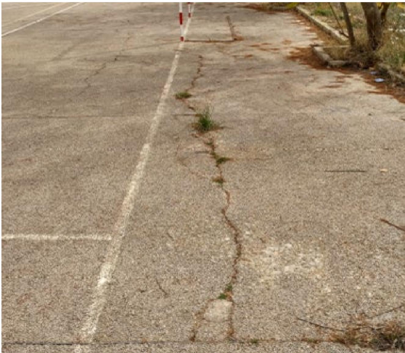
Imagen 4. Lesiones en pista de hormigón drenante
