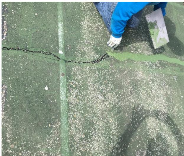
Fig. d. Aplicación Ultrabond Turf 2 Stars
