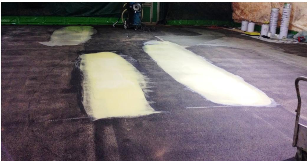
Fig. e. Reparación del bache con Mapecoat TNS Base Coat
