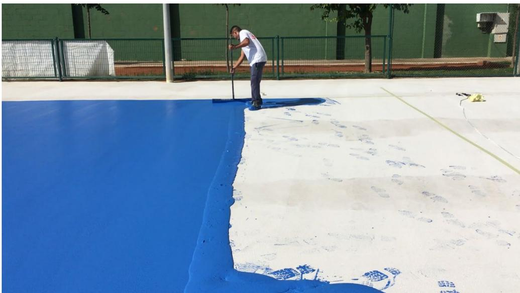
Fig.g. Aplicación de capa base de Mapecoat TNS Finish 1.3.4
