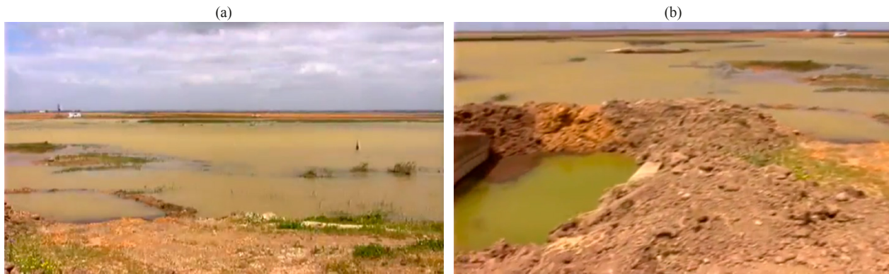
Figura 9 | Comportamiento del fluido (ubicación #7): situación del cauce tras el paso de la avenida, Vado Los Vaqueros en el río Guadiamar.
