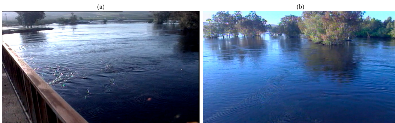
Figura 6 | Comportamiento del fluido (ubicación #3): laminación de la avenida, puente de la carretera A-472 sobre el río Guadiamar.
