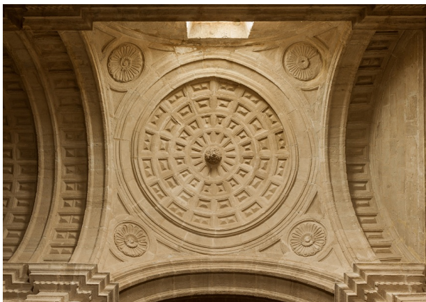
Fig 1. Bóveda baída por hiladas redondas sobre planta cuadrada en la Iglesia de Santiago Apóstol (Orihuela, Alicante). 2012.
