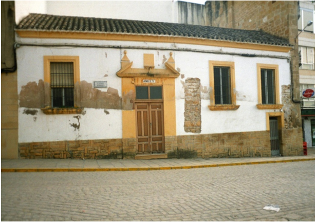
Fig 1. Edificio antes de ser intervenido. 2001. Fototeca ARQVIPO.
