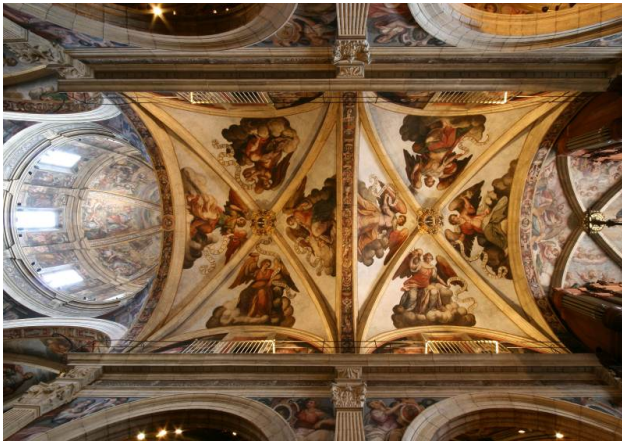
Fig. 6. Plementos de la nave de la iglesia del Patriarca. 2012. Fuente propia
