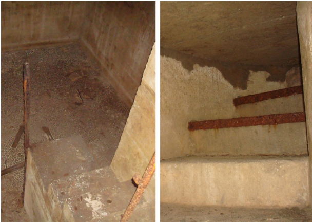
Fig 4. Aljibe en desuso. Escalera de caracol cegada por forjado. Estado actual. 2011. Fuente: elaboración propia.
