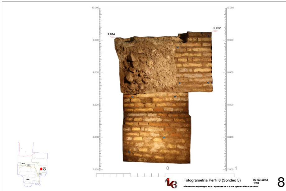
Fig. 4. Presentación de un ortofotoperfil estratigráfico obtenido mediante la composición de tres tomas fotográficas por la metodología propuesta. Detalle de restos de cimentación y muro originales. 2012. Fuente: Elaboración propia. Catedral de Sevilla.
