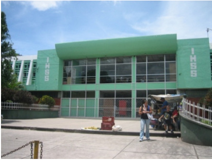
Fig. 6. Vértice IHSS, en la azotea del edificio, acceso con escalera
