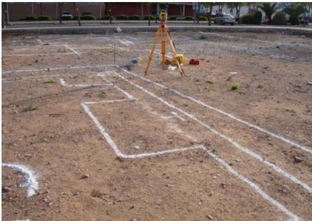
Fig. 8. Práctica de replanteo, realizada por los alumnos Cristian Boix, Lourdes Casado, Ester Donaire y Vicente Monferrer, consistentes en materialización de un replanteo sobre el terreno de la cimentación de un edificio, Campus Universidad, Castellón, curso 2010-11.
