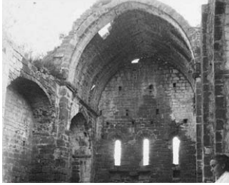
Fig. 2 Sant Genís de Rocafort. Martorell 1912. Pobles de Catalunya-Fons Salvany Biblioteca de Catalunya,
