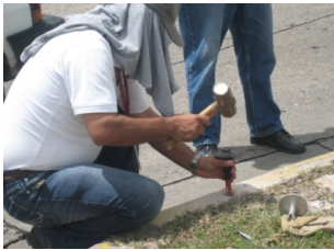
Fig. 7. Trabajos de monumentación
