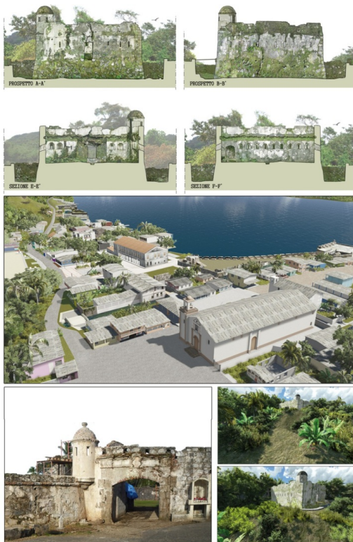
Fig 5. Portobelo a Panama, rilievo eseguito per la documentazione del patrimonio storico della baia e per l'analisi del pueblo. Molte fortezze e resti di fortificazione sono state scoperte grazie a queste campagne di rilevamento che hanno permesso di ricucire la storia della baia stessa. Nelle fotografie sono evidenti i lavori di restauro e consolidamento delle fortezze che stanno alterando completamente l'immagine, il disegno, del paesaggio della baia.
