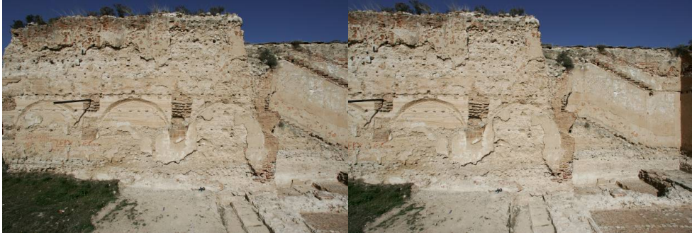
Fig. 1. Modelo fotogramétrico que permite formar la imagen estereoscópica.
