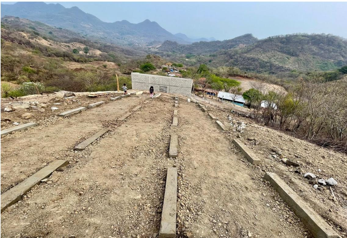
ILUSTRACIÓN 7. SOPORTE PARA LAS PLACAS SOLARES
