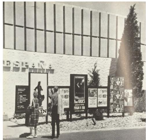
Fig. 76. Fotografía exterior fachada grecada de primera planta y muros enfoscados en planta baja.
