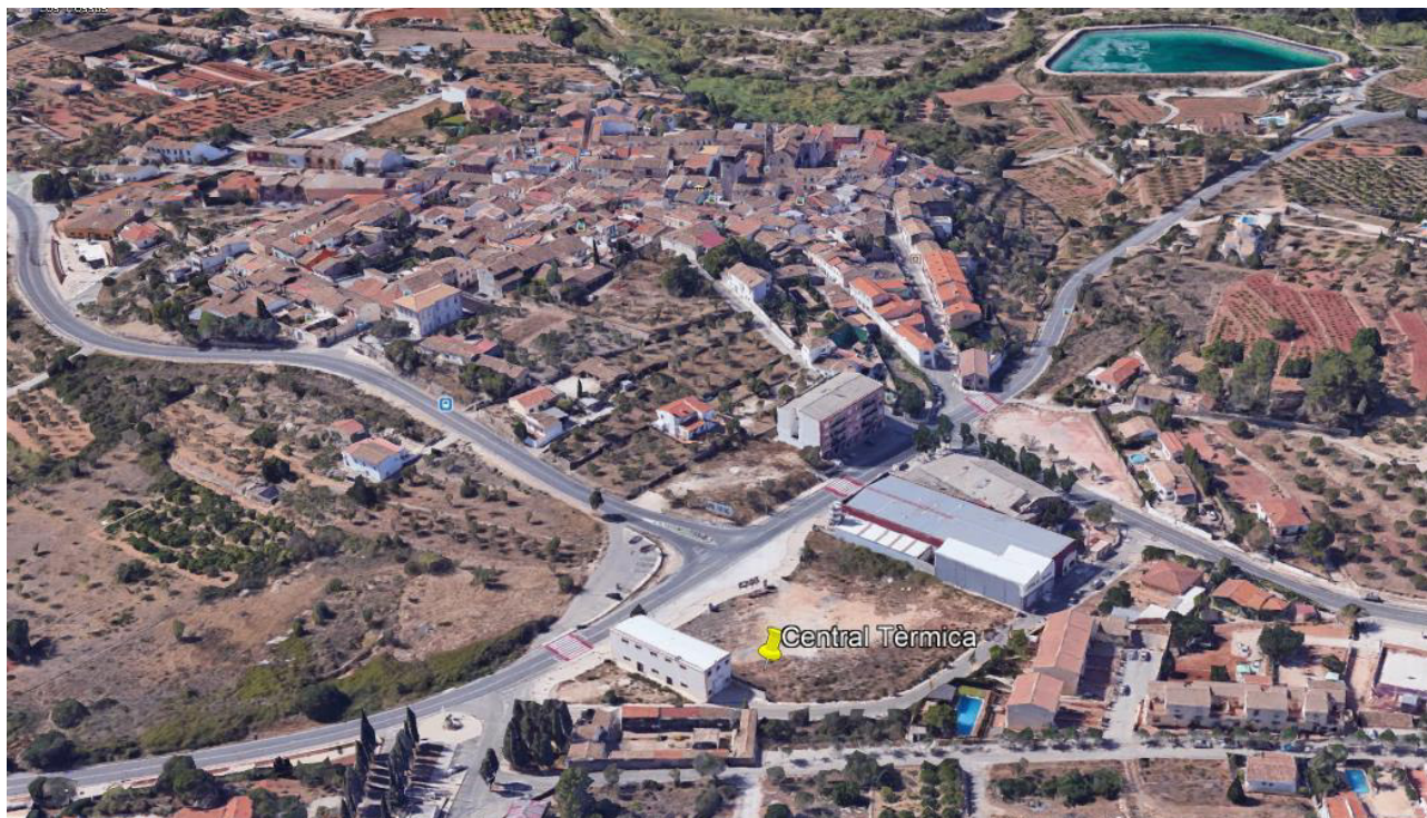
Figura 11. Situació de la parcel·la on s'ubicarà la Central Tèrmica. Font: Google Earth
