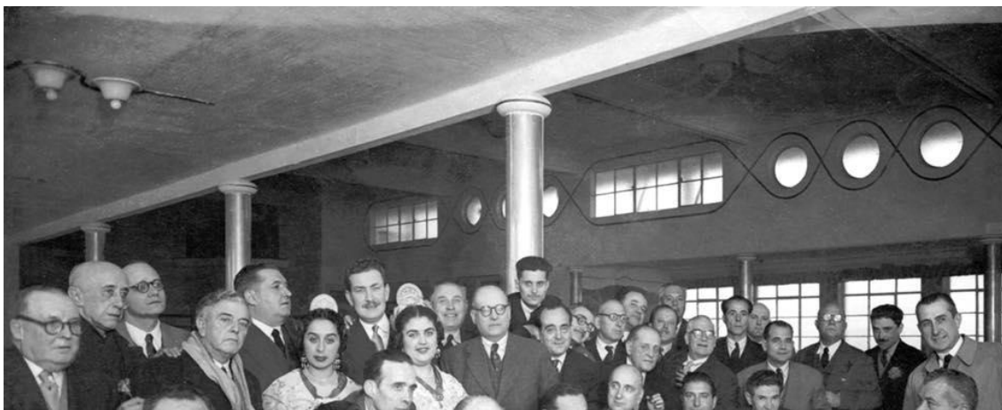
Figura 40. FUNDACIÓN GOERLICH. (1950). Estructura de pilares metálicos circulares.
