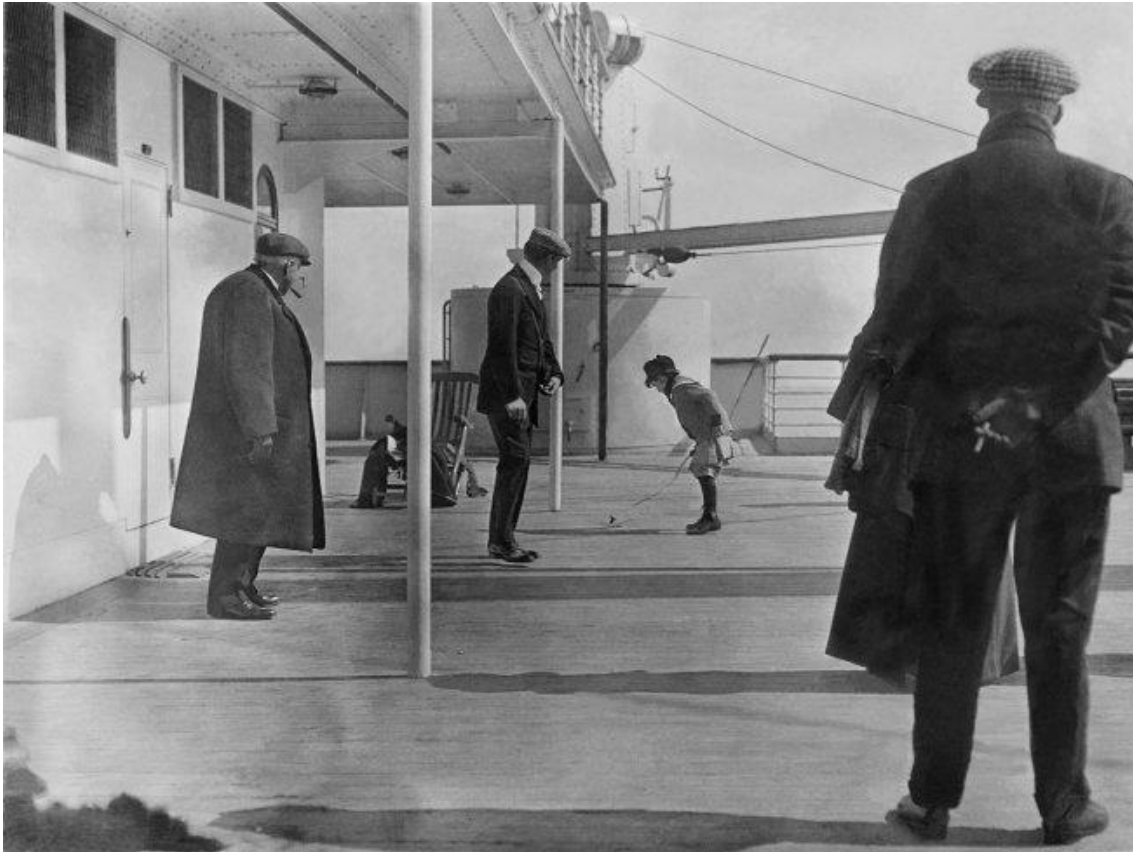
Figura 19. BROWNE, F. (1912). Pilares de perfiles tubulares.
