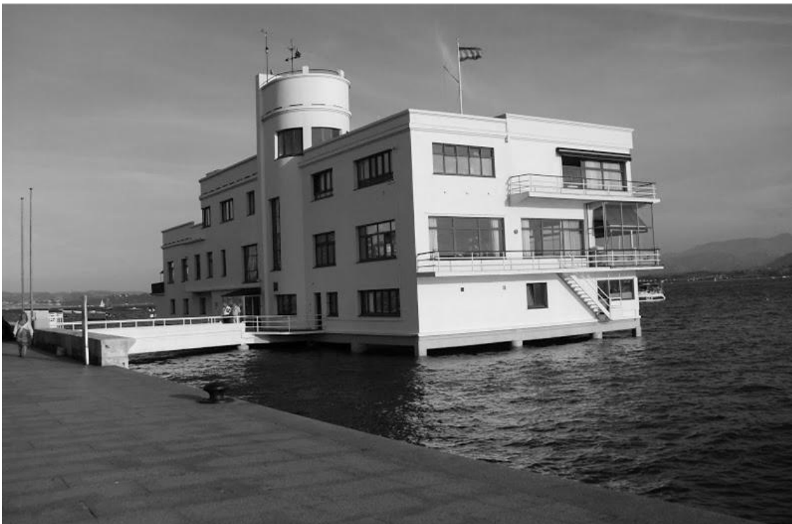
Figura 62. LITO. (2010). Fachadas norte y oeste de la obra.
