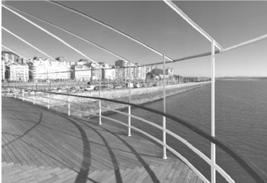
Figura 64. ONAINDIA, J. (2017). Barandilla tubular metálica de la cubierta de paseo.
