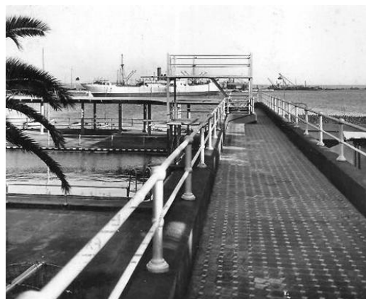
Figura 43. ROISIN, L. (1939). Barandillas de perfiles tubulares.
