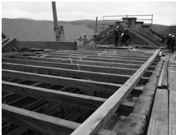
Figura 3.14. Forjado y cubierta madera aserrada (fuente: Confemadera, 2010)
