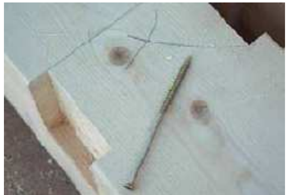
Figura 7.12. Ensamble a cortante en cola de milano (fuente: Cismadeira)
