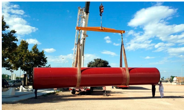
Figura 15. Instalación del tubo en 2017 (Fuente: Hyperloop UPV)
