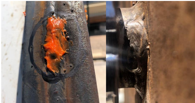
Figura 66. Defectos detectados en el cordón de soldadura
