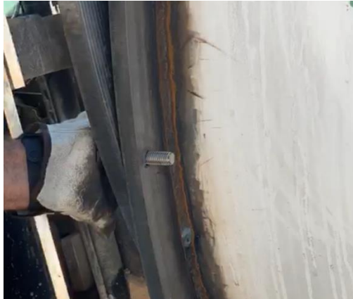
Figura 63. Montaje de una de las compuertas.
