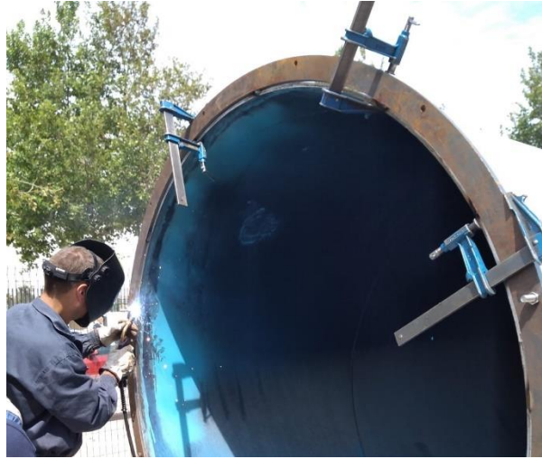
Figura 62. Colocación y soldadura de las bridas.
