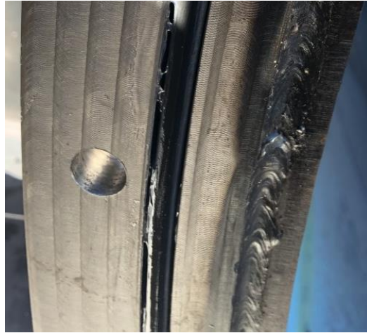
Figura 23. Junta colocada en su ranura
