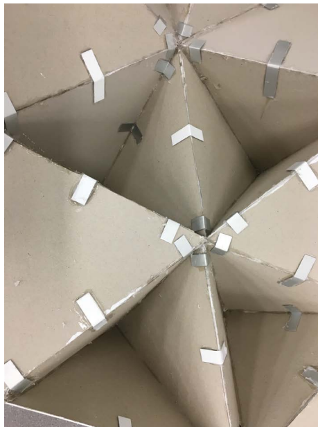
Fig. 16-17. Ensamblaje mediante pletinas de aluminio y adhesivo sellador. 2018.
