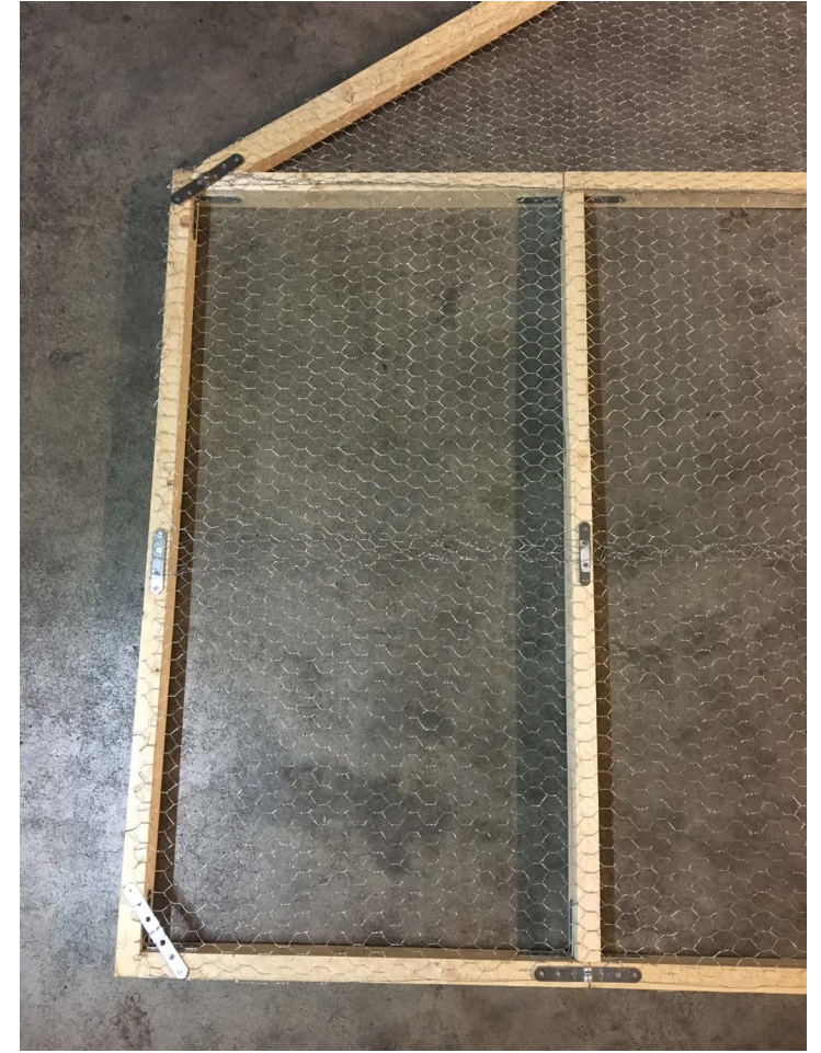
Fig. 8. Ensamblaje de la rejilla metálica sobre el bastidor. 2019.
