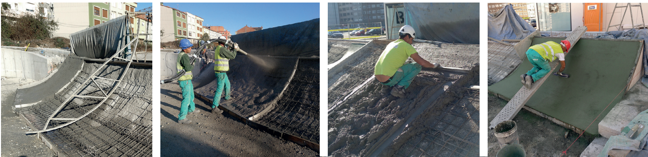
Figure 5. Curved ruler to set out the surface, application of the gunite (two operators counteract the pressure exerted by the pump) and flattening after the application of silica sand / Figura 5. Regla curva de replanteo de la superficie, aplicación de la gunita (dos operarios contrarrestan la presión que ejerce la bomba), regleteado y llaneado tras la aplicación de la arena de sílice.
