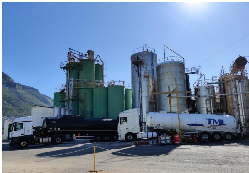
Ilustración 7: Silos de almacenamiento del betún.
