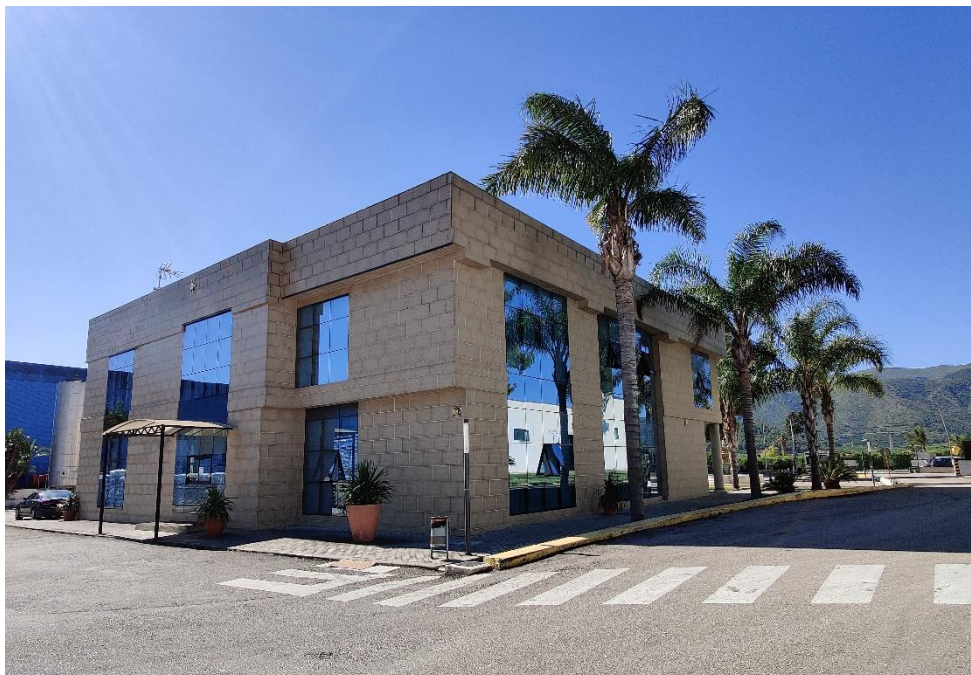
Ilustración 2: Oficinas centrales de Chova.
