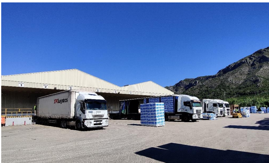
Ilustración 9: Muelles de carga del almacén
