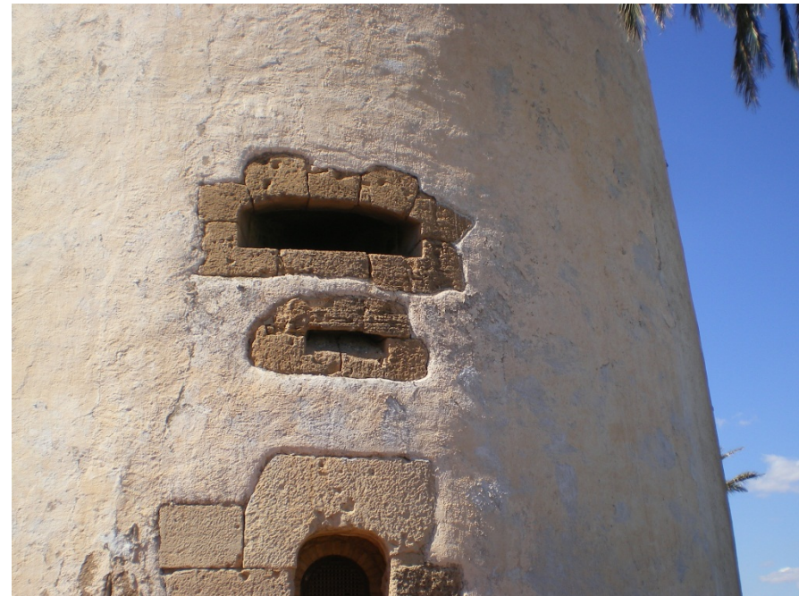
Foto de abril de 2012, se aprecian las troneras en el tronco de la torre ejecutadas con sillarejos de arenisca.
