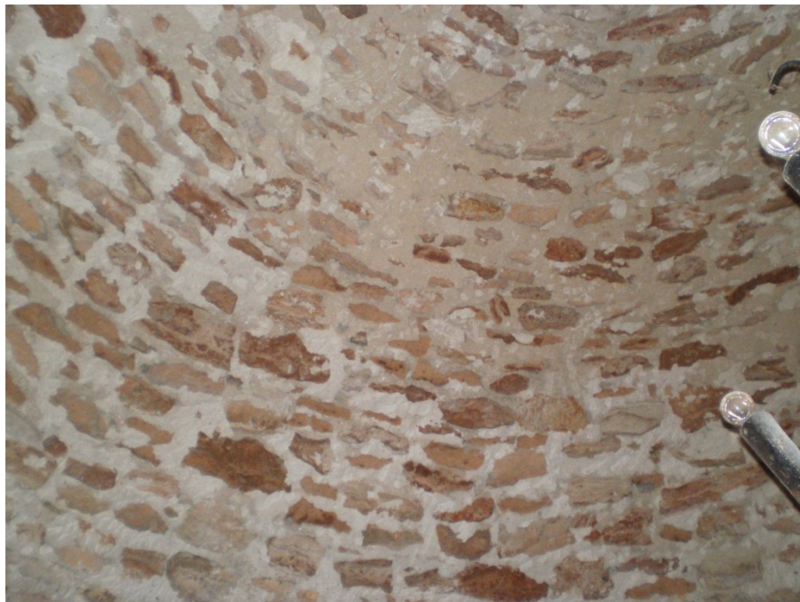
Foto de abril de 2012, donde se observan el muro y el comienzo de la cúpula de mampostería.
