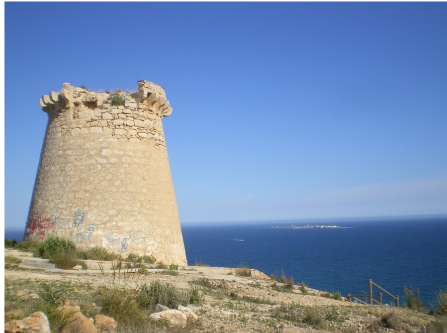
Torre de Escaletes. Abril de 2012
