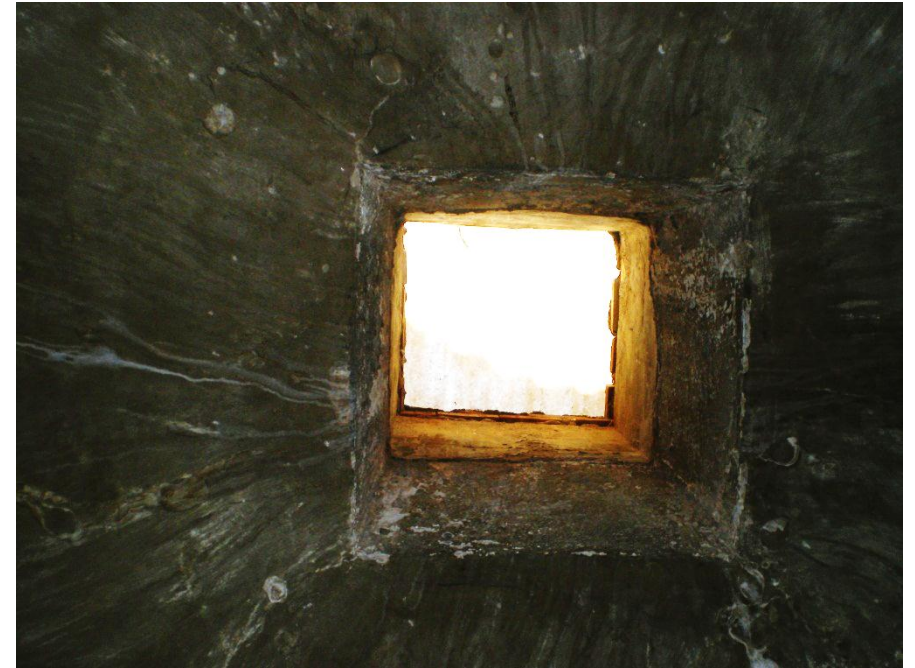
Techo de planta 2, foto abril de 2012
