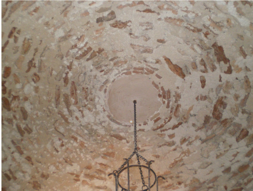
Techo de planta 1, foto abril de 2012
