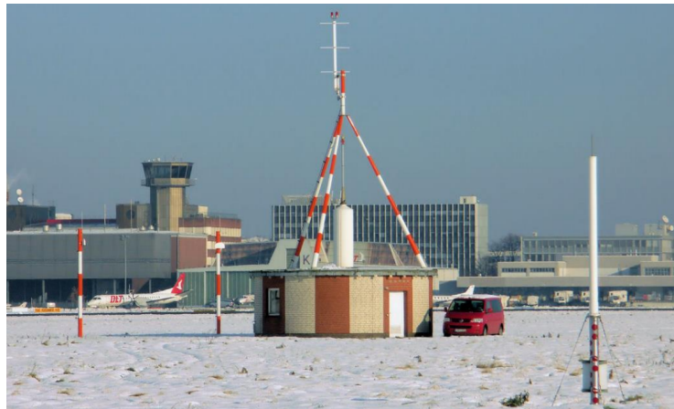
Figura 3.3: Estación de tierra del GBAS de Bremen [20]
