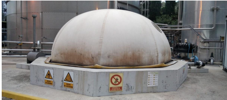
Figura 7. Gasómetro de la EDAR objeto de estudio
