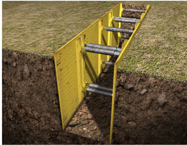
Representación gráfica de la unidad de obra ADE010, zanja con apuntalamiento metálico
