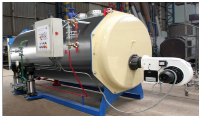
Figura 6. Caldera de vapor serie MINOR de la EDAR objeto de estudio
