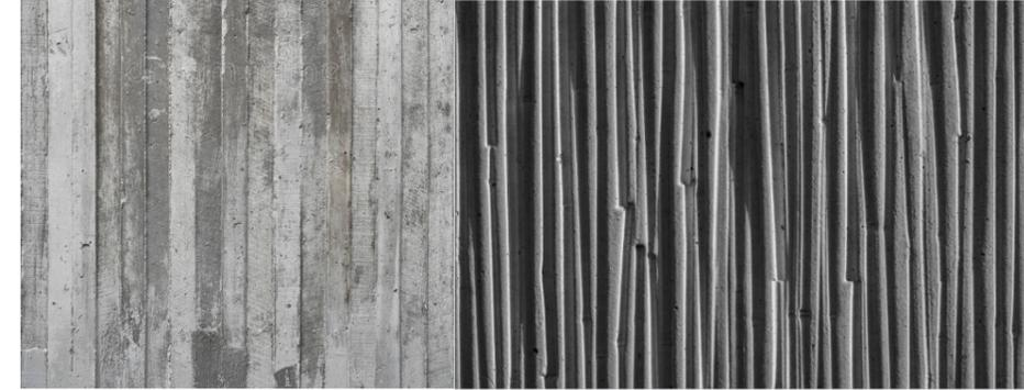
Textura del acabado de la capa exterior de los paneles GRC
