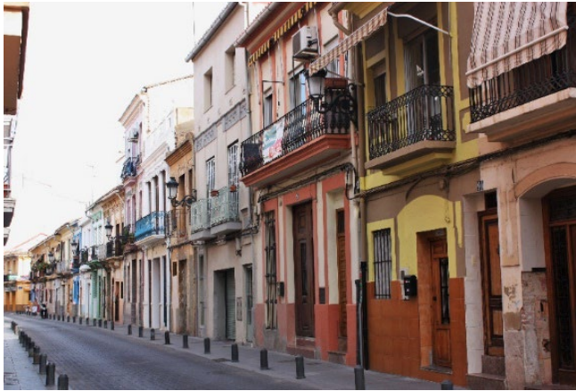
Figura 2. Vista calle Rosario. (Pastor, R. 2012)
