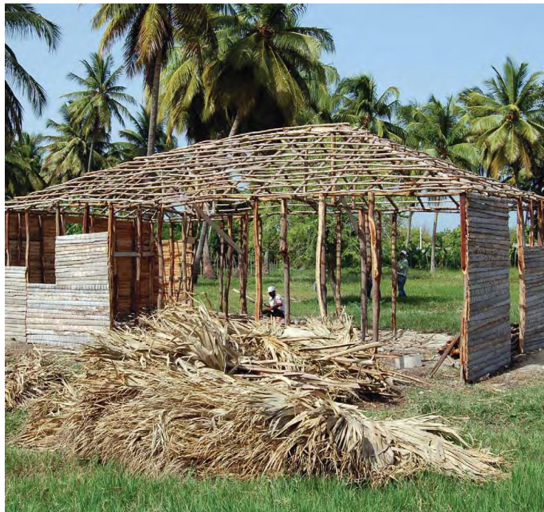
Fig.12 | Construcción del tejamanil Fuente: Luis Gustavo Moré 4
