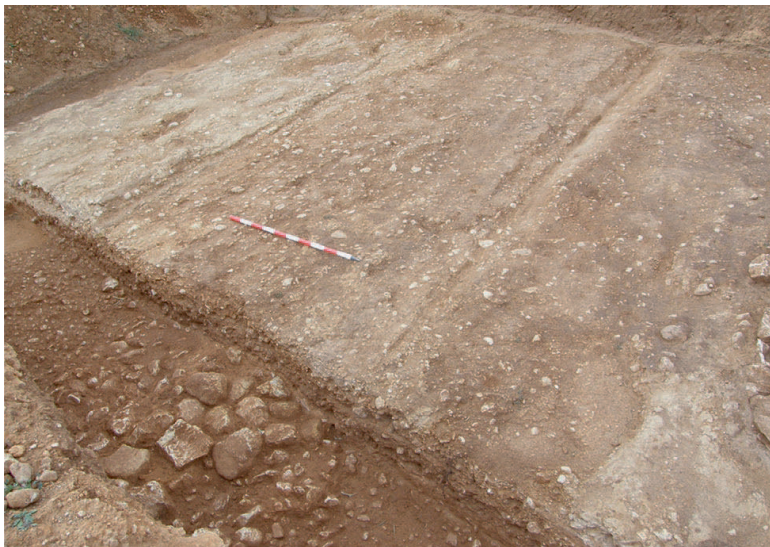
Fig. 180 Superficie de rodadura y cimentación de la Vía Augusta
