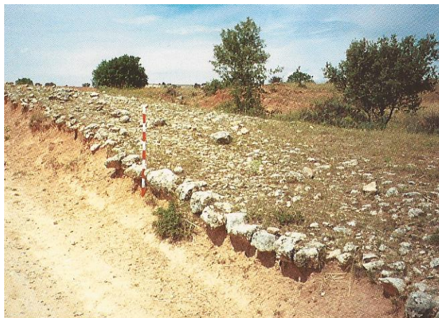
Fig. 14 Firme Vía Romana Palencia
