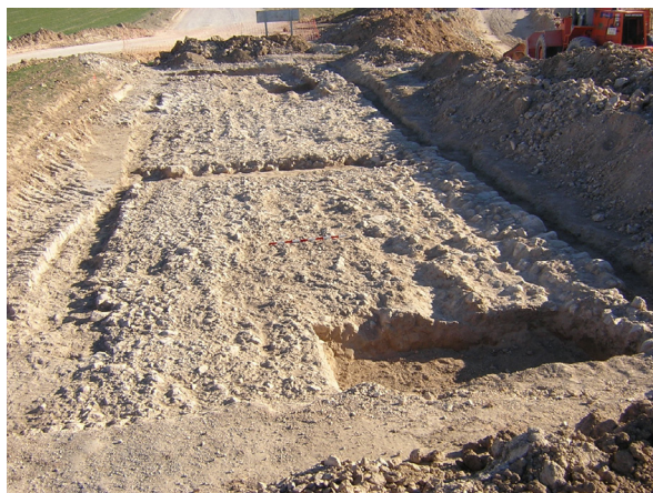
Fig. 194 Excavación camino a Villena Año 2004
