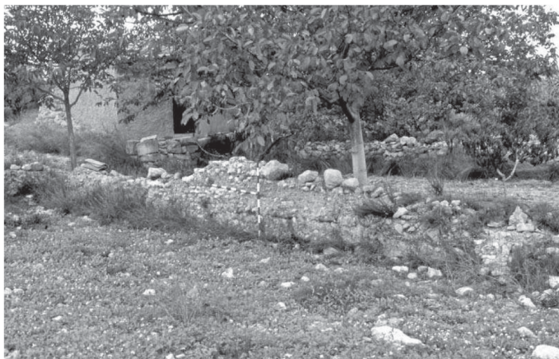
Fig. 116 Muro de opus caementicium Sector I
