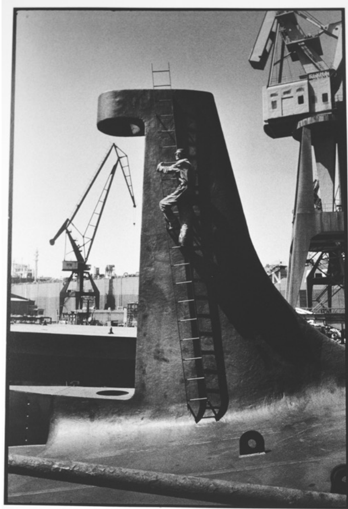
Fig. 61. Inspección del codaste antes del traslado para su montaje en el buque. El nacimiento de un barco en Astilleros Españoles. (1994).
