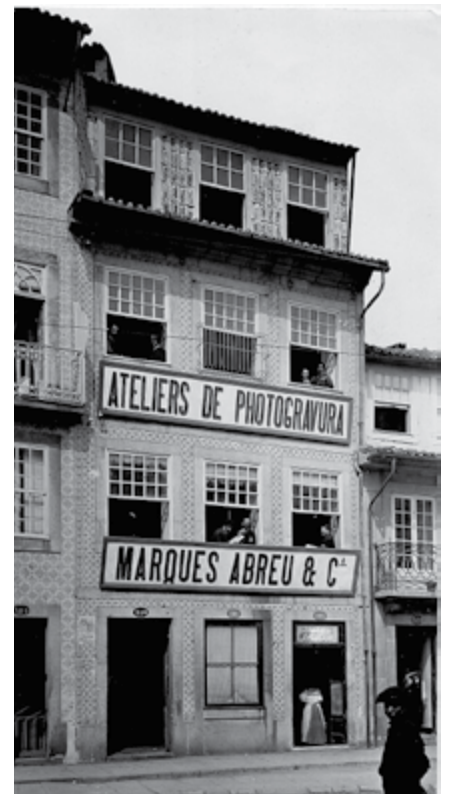
Edifício na rua S. Lázaro que serviu de habitação, escritório, ateliê e Oficina
