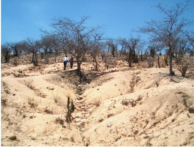
*Foto 1. Cárcava con un pequeño bordo de piedra acomodada para controlar la erosión en Sierra La Trinchera, (Cuenca El Carrizal)*
