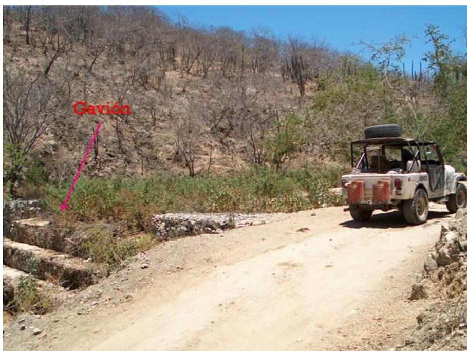
*Figura 108. Utilización de un gavión en la parte alta de la cuenca de La Palma*
