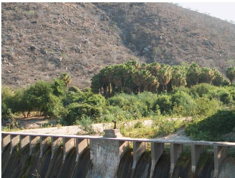
*Foto 5. Presa El Salto en la cuenca El Carrizal, totalmente azolvada (aterrada) con sedimentos de la parte oriental de la cuenca (Sierra La Trinchera)*
