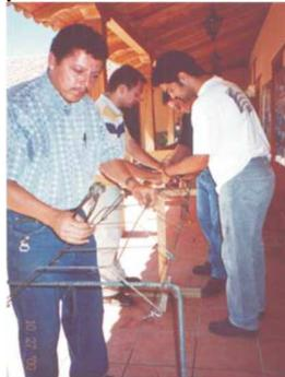
Fig. 21. Preparación de la armadura. Fuente: Pedro Lorenzo Gállego 2005. Un techo para vivir.
