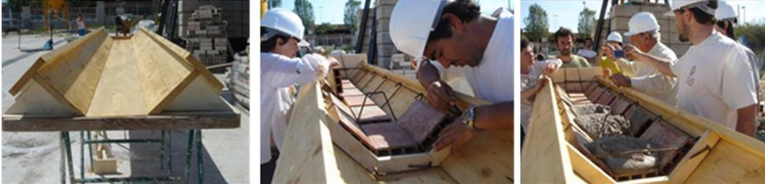
Fig. 23. Izquierda: preparación molde. Medio: molde preparado. Derecha: Vertido de material. Fuente: Rosa Ana Jiménez 2010.
