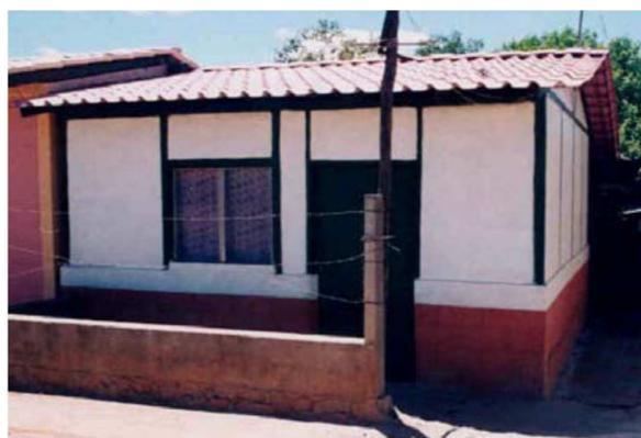
Fig. 28 Izquierda: proceso constructivo del cerramiento. Derecha: vivienda con cerramientos de quincha prefabricada revestida exteriormente. Fuente: Pedro Lorenzo Gállico 2005. Un techo para vivir.
