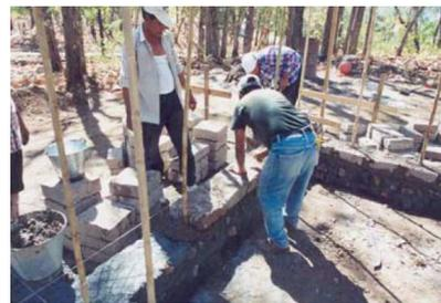
Fig. 24. Izquierda: construcción con bloques de adobe sismorresistente. Derecha: proceso constructivo. Fuente: Pedro Lorenzo Gállico 2005. *Un techo para vivir*.
