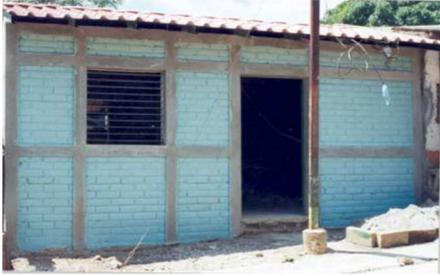
Fig. 31. Cerramiento de ladrillo de cemento en vivienda finalizado. Fuente: Pedro Lorenzo Gállego 2005. Un techo para vivir.
