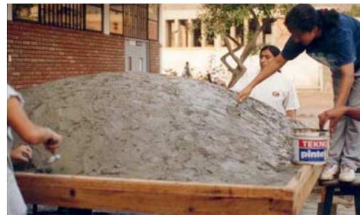
Fig. 12. Izquierda: Montaje de la estructura de la cúpula. Derecha: Recubrimiento con mortero. Fuente: Pedro Lorenzo Gállego 2005. Un techo para vivir.
