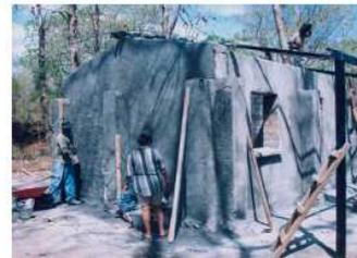
Fig. 27. Izquierda: Realización del muro. Derecha: revestido exterior de las paredes. Fuente: Pedro Lorenzo Gállego 2005. Un techo para vivir.
