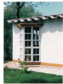
Fig. 20. Izquierda: vivienda en construcción con módulos autoportantes de cerámica armada. Derecha: vivienda finalizada. Fuente: Pedro Lorenzo Gállico 2005. Un techo para vivir.
