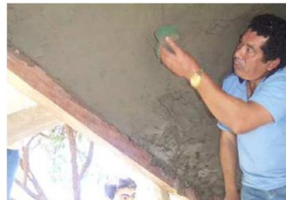
Fig. 13. Montaje de la estructura de la cúpula. Recubrición con mortero. Fuente: Pedro Lorenzo Gállego 2005. Un techo para vivir.
