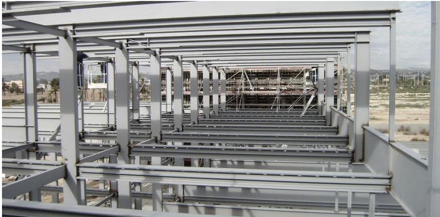
Ilustración 50. Estructura pórticos metálicos en la obra. [13]
