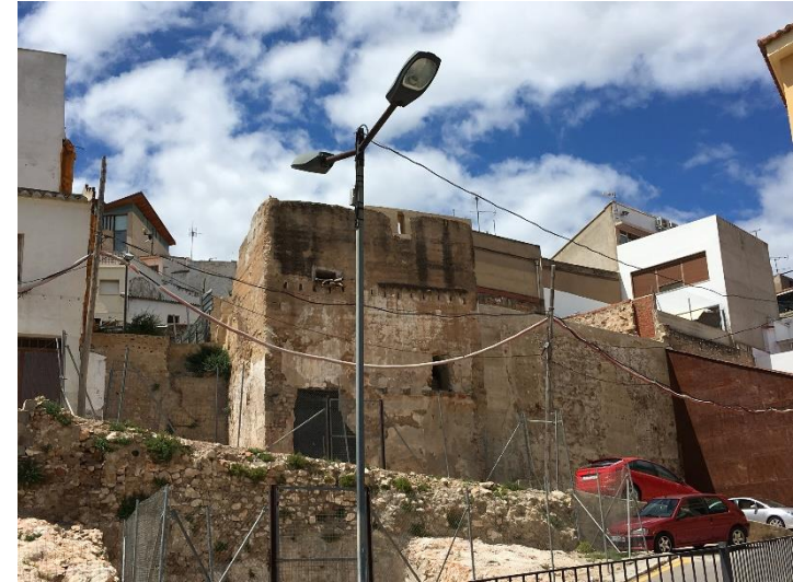
Imagen 42: Situación actual Pont de Vidre
