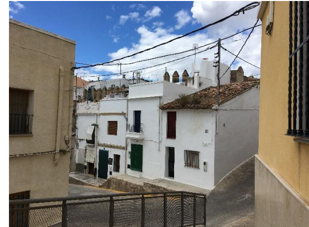
Imagen 44: Situación actual lienzo de Muralla vista desde la calle de Pompeyo
