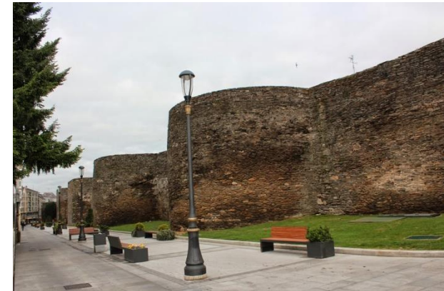
Imagen 83: Proyecto Restauración Muralla de Lugo - España Fuente: Cultura de Galicia https://www.cultura.gal/es/conservacion-restauracion-muralla-romana-lugo (Fecha de consulta: 16 de agosto de 2017)
