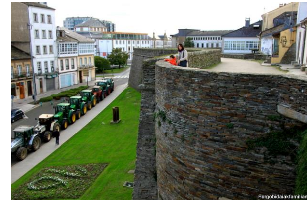
Imagen 84: Proyecto Restauración Muralla de Lugo - España Fuente: Cultura de Galicia https://www.cultura.gal/es/conservacion-restauracion-muralla-romana-lugo (Fecha de consulta: 16 de agosto de 2017)
