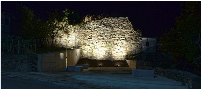
Imagen 74: Acondicionamiento Muralla Medieval de Manzaneda. 2016 Fuente: Luis Álvarez Arquitectura. "Acondicionamiento de plaza como punto interpretativo de la Muralla Medieval de Manzaneda". Orense, 2016 https://luisalvarezarquitectura.es/espacio-publico-humanizacion-paisajismo/ (Fecha de consulta: 16 de junio de 2017)
