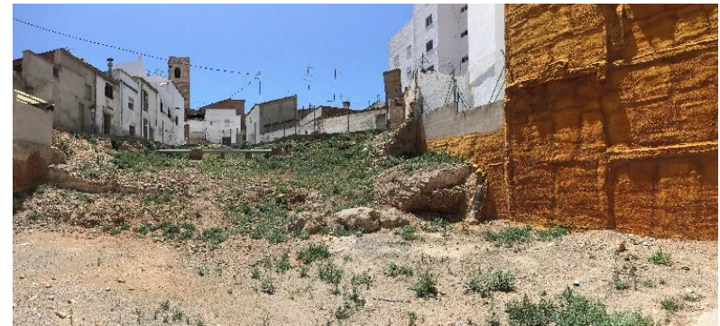
Imagen 63: Restos cimentación antigua torre, calle del Remei
