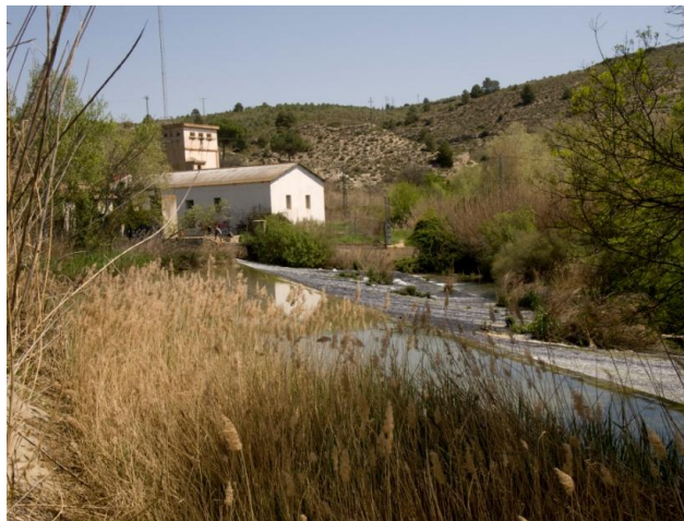
Figura 9. Central hidroeléctrica de "Bolinches", Albacete
