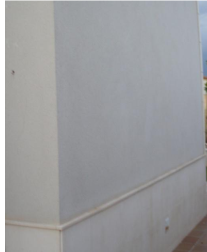
Figura 14. Parte opaca. Muro de fachada
