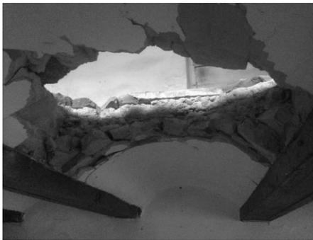
Ilustración 17. Sección forjado tipo A
